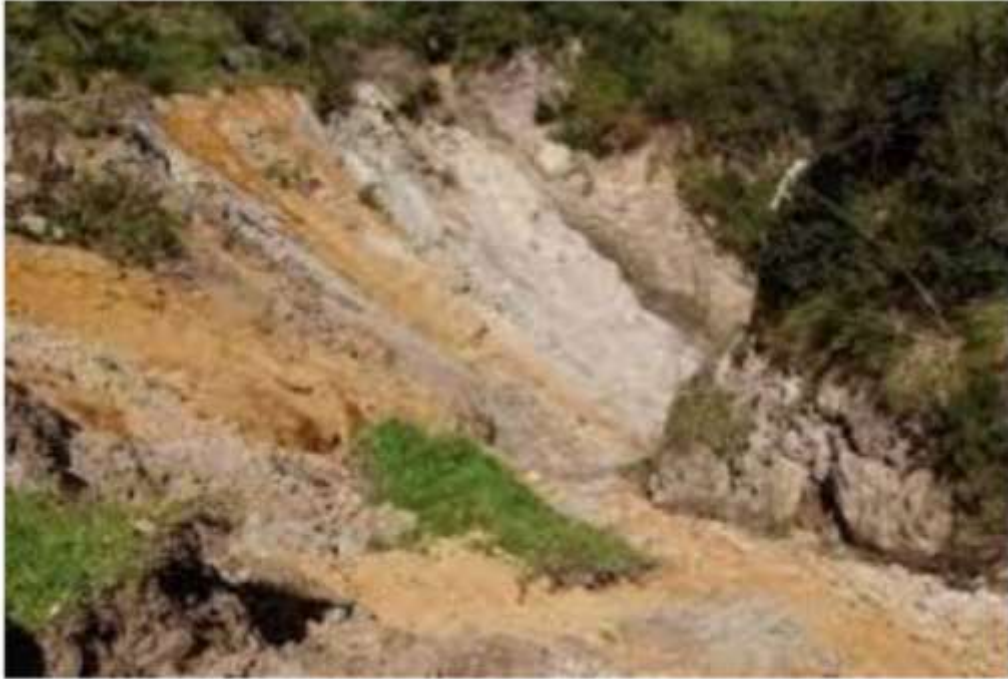
Anexo 18. Degradación cerca de la captación de Nudpud.
