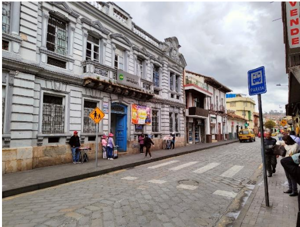
Figura 57 Colegio San Francisco, calle Tarqui.
