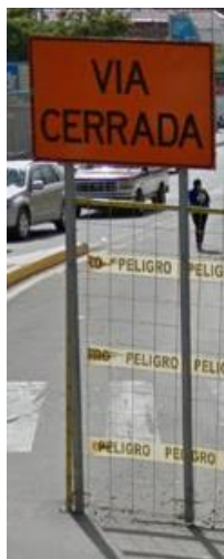
Grafico 24 Señal de vía cerrada Fuente: Propia
