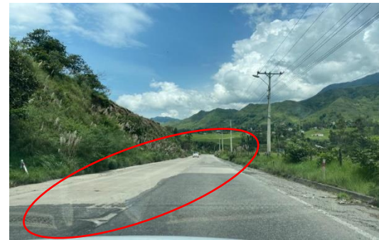
Ilustración 18 Deterioro de carpeta asfáltica en varios tramos de la vía Fuente: Propia
