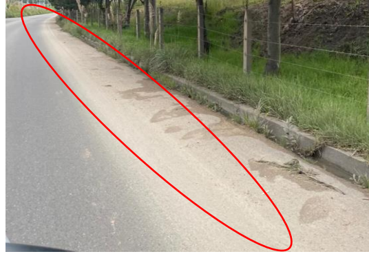
Ilustración 12 Delineación en mal estado Fuente: Propia
