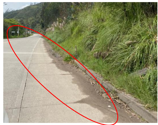
Ilustración 8 Mal drenaje en la vía en varios tramos Fuente: Propia
