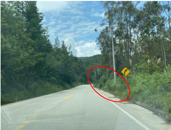
Ilustración 3 Distancia visibilidad opacadas por la vegetación y derrumbes Fuente: Propia
