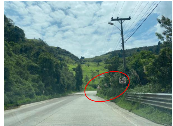
Ilustración 3 Distancia visibilidad opacadas por la vegetación y derrumbes Fuente: Propia
