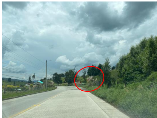
Ilustración 10 Señalización Vertical tapada por vegetación Fuente: Propia
