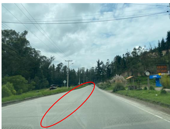
Ilustración 11 Señalización Horizontal en mal estado Fuente: Propia
