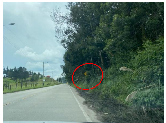
Ilustración 10 Señalización Vertical tapada por vegetación Fuente: Propia
