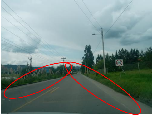
Ilustración 12 Delineación en mal estado Fuente: Propia
