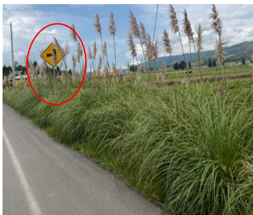
Ilustración 5 Señalización de intersecciones tapadas por vegetación. Fuente: Propia
