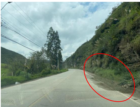
Ilustración 8 Mal drenaje en la vía en varios tramos Fuente: Propia
