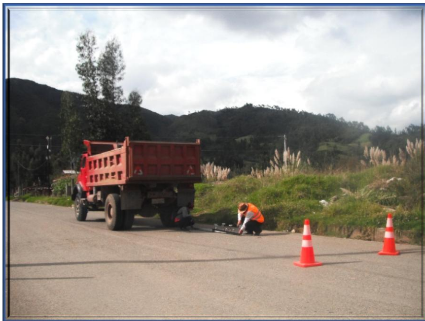
Fotografía 25. Ensayo de deflexión Fuente: Autoras
