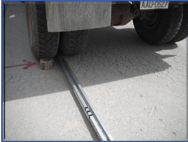
Fotografía 27. Colocación Típica de la VIGA DE BENKELMAN
