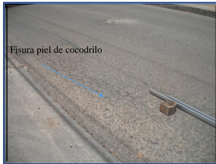
Fotografía 10. Fisura piel de cocodrilo, abscisa 2+650 Fuente: Autoras
