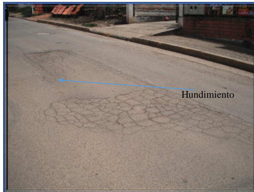
Fotografía 14. Hundimiento
