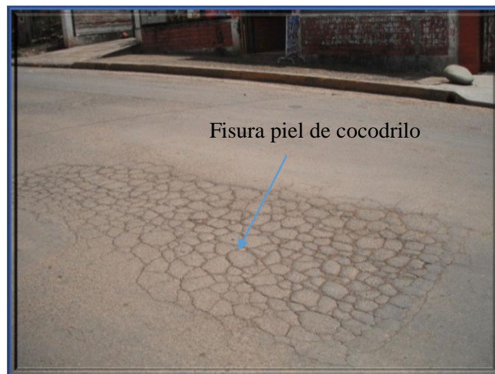
Fotografía 7. Fisura piel de cocodrilo, abscisa 0+400
