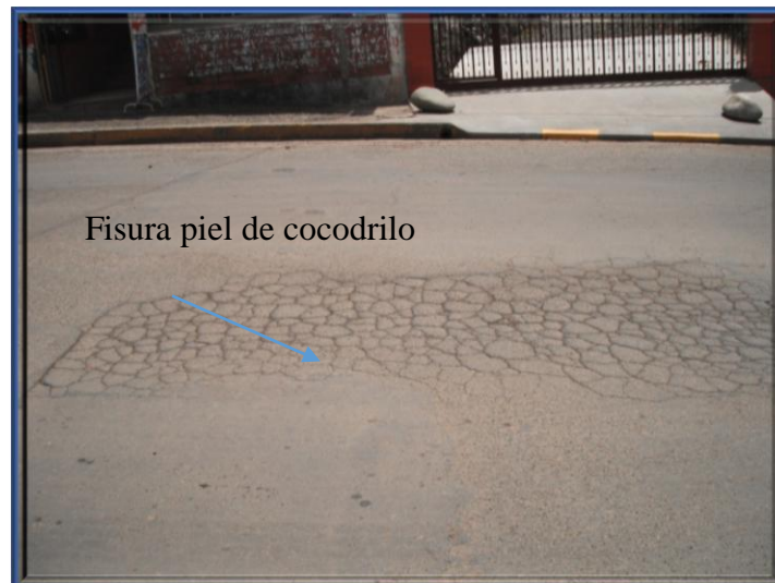
Fotografía 8. Fisura piel de cocodrilo, abscisa 1+600 Fuente: Autoras
