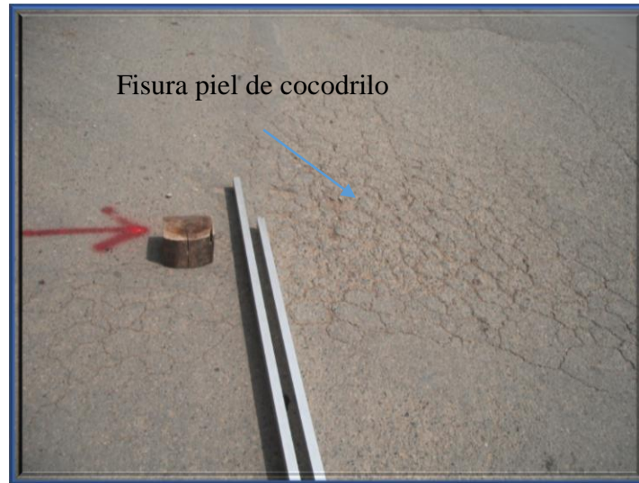
Fotografía 8. Fisura piel de cocodrilo, abscisa 1+600 Fuente: Autoras
