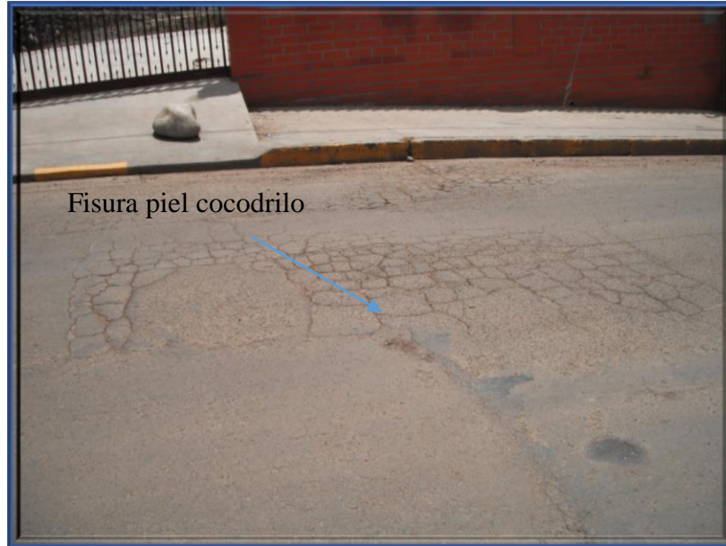
Fotografía 10. Fisura piel de cocodrilo, abscisa 2+650 Fuente: Autoras
