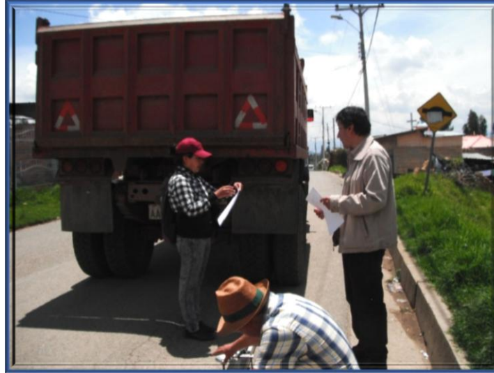
Fotografía 21. Medición de deflexiones en coordinación con el Ing. Marcelo Torres tutor de tesis delegado del GAD MUNICIPAL DEL CANTON CUENCA
