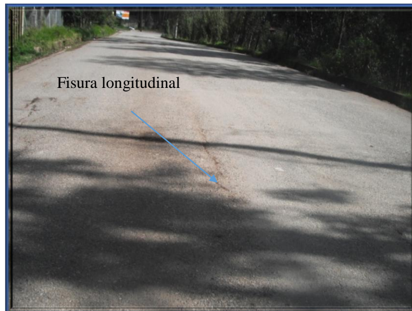
Fotografía 1. Falla longitudinal en el centro de la vía, abscisas 5+052
