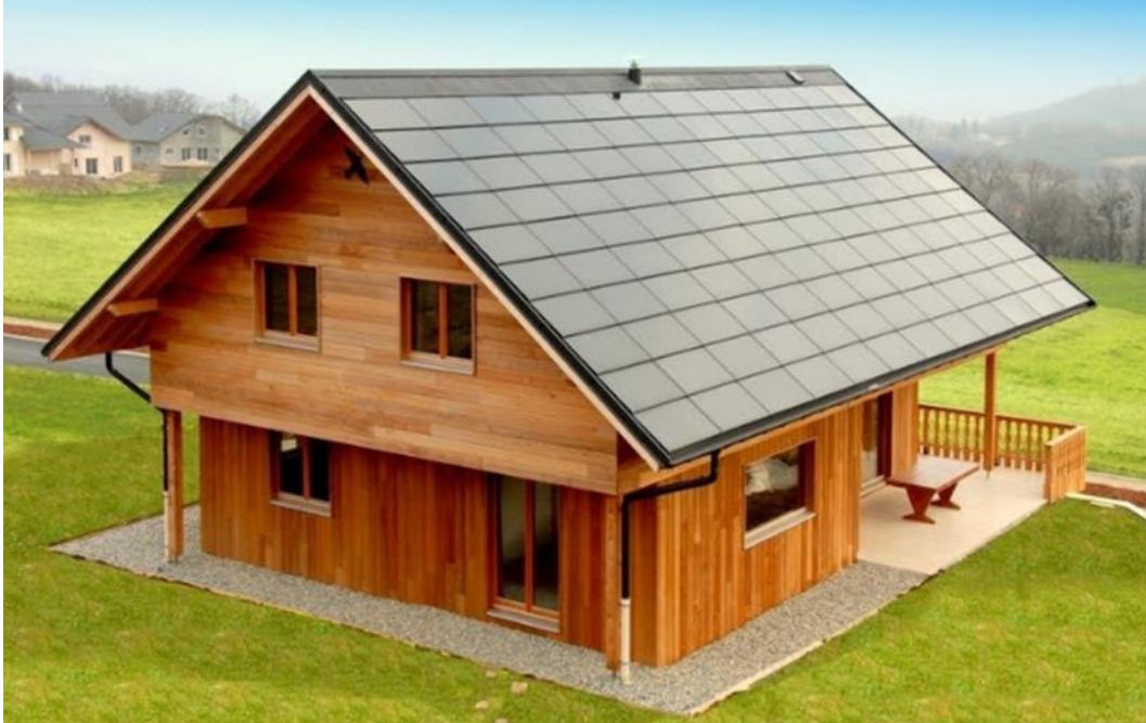
Figura 8. Vivienda con energía solar fotovoltaica Fuente: (ENERGIA SOLAR, 2014)
