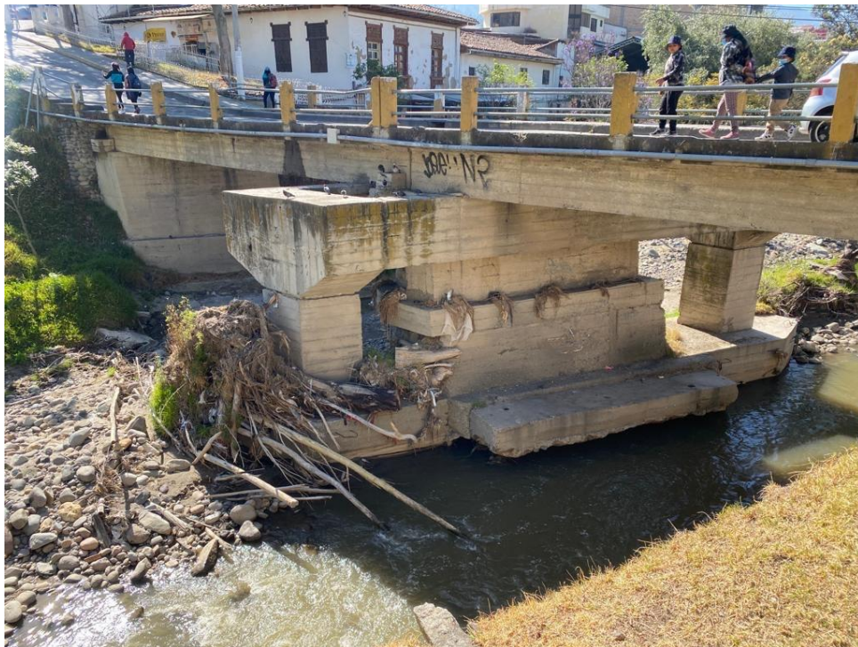
Figura 1: Pila central del puente 10 de agosto
