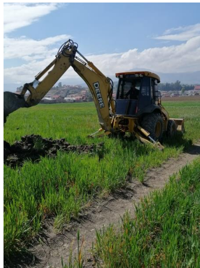
Figura 26. Calicata 2, para extracción de muestra
