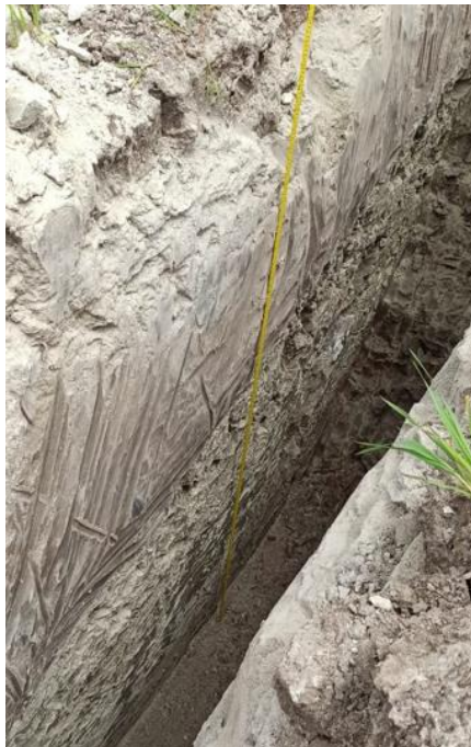
Figura 29. Estratigrafía Visual punto de extracción Calicata 2
