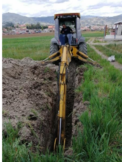
Figura 25. Calicata 1, para extracción de muestra
