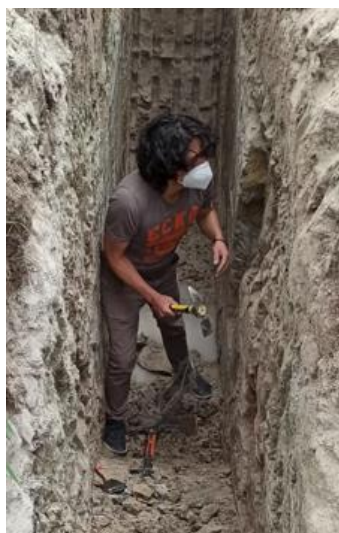
Figura 27. Labrado y extracción de muestra inalterada en la pared de la zanja
