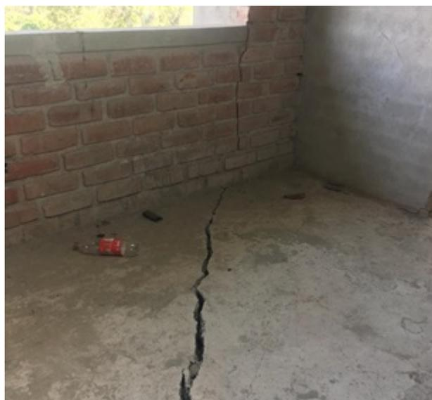
FIGURA 2.7: *Grietas en pisos consecuencia de autoconstrucción*
