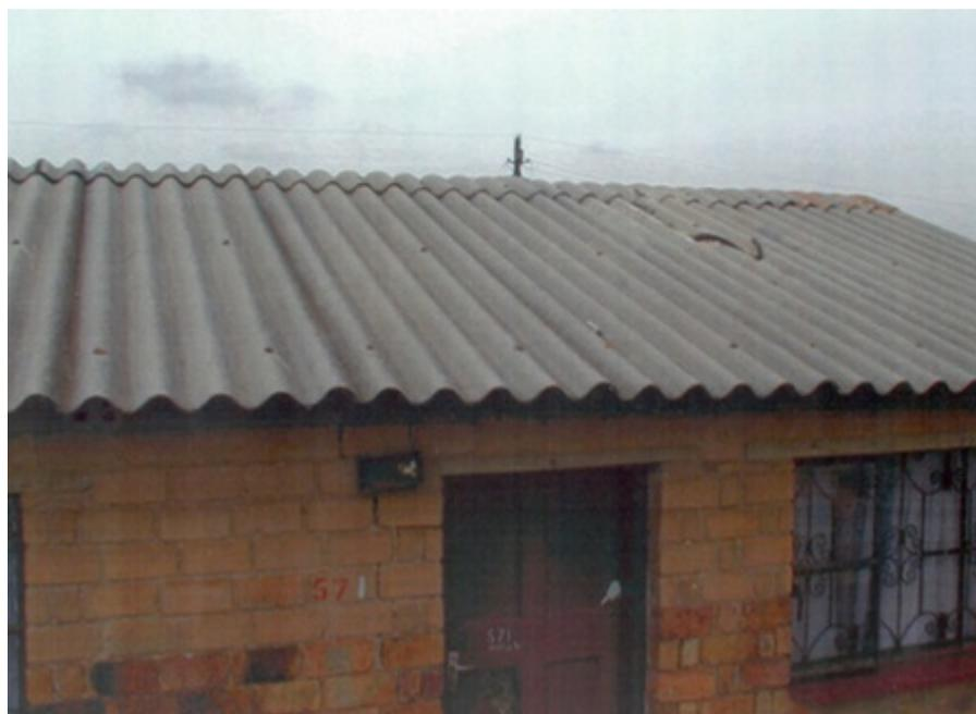
FIGURA 2.6: *Techo con asbesto en vivienda autoconstruida*
