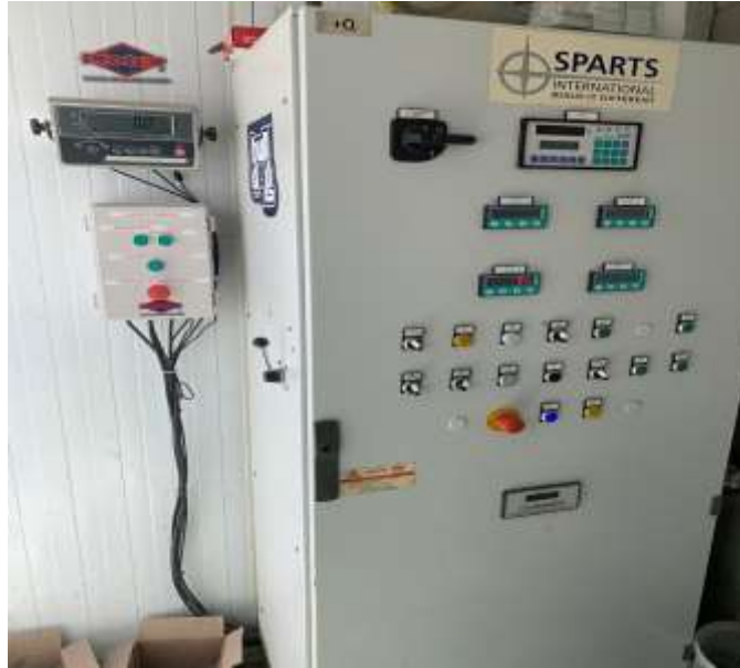
Figura 9: Panel de la planta de hormigón Fuente: Hormi – Center Elaborado por: Autora
