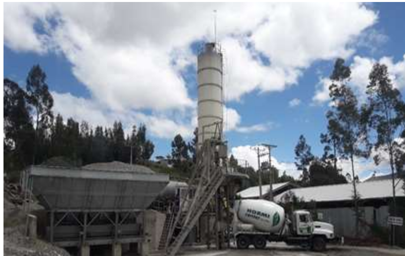
Figura 10: Descarga del Hormigón Premezclado a los Mixer Fuente: Planta Hormi – Center Elaborado por: Autora
