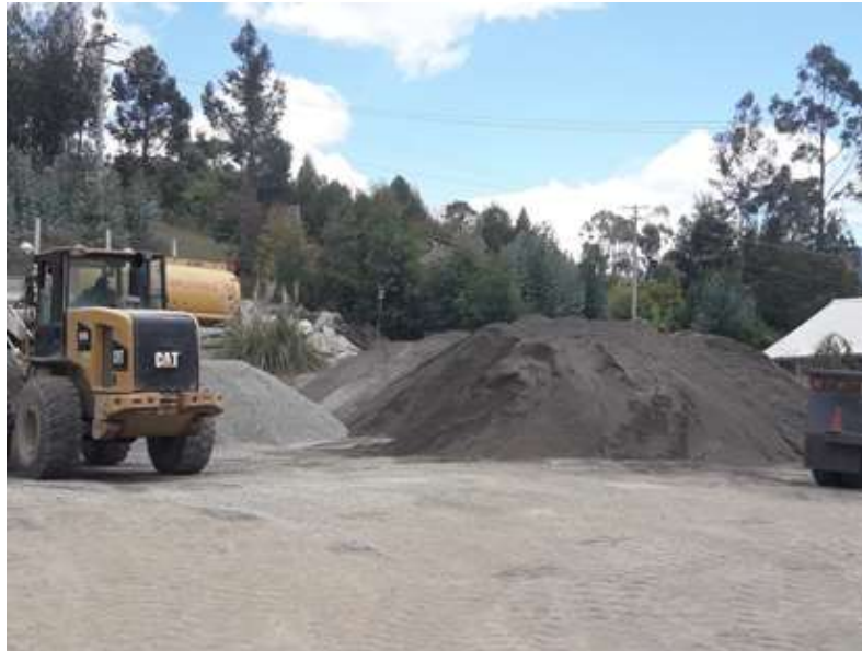
Figura 4: Almacenamiento de los materiales (Áridos)
