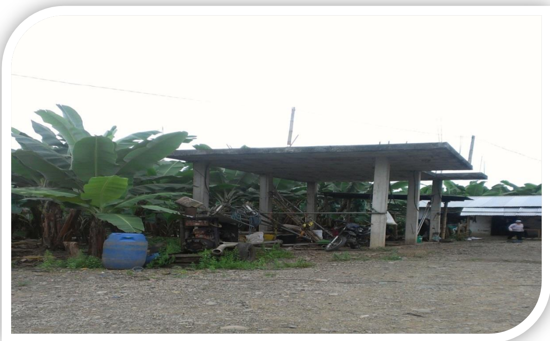
Infraestructura de Bodega
