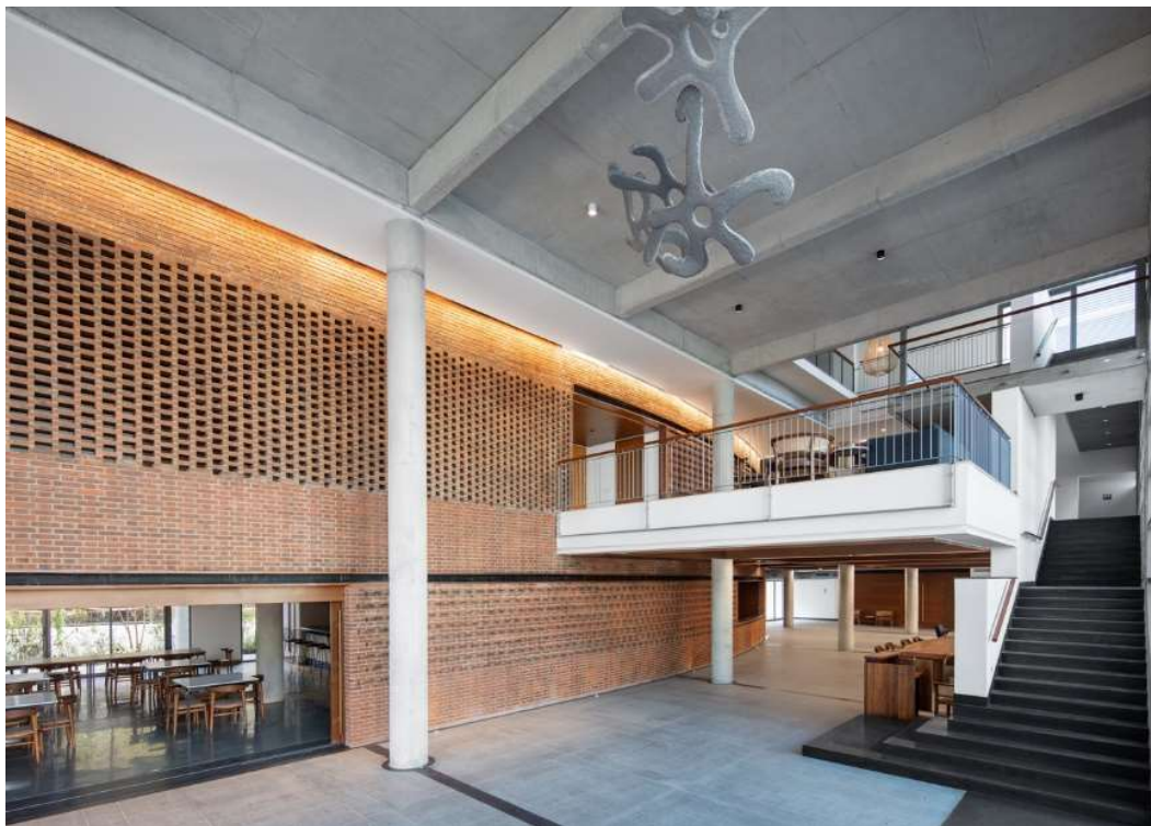
Figura 12: Estructura portante y vanos
