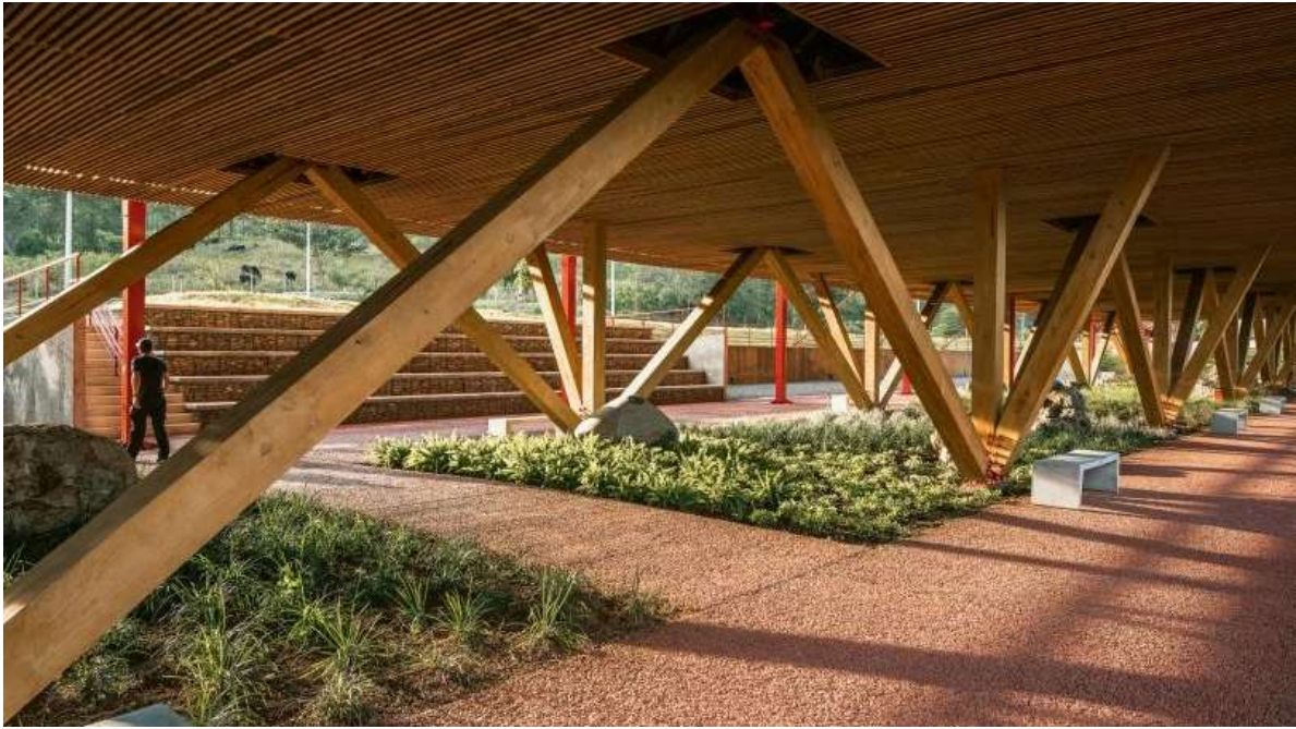
Figura 34: Fotografía sistema portante en PB
