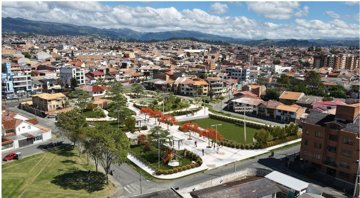
Figura 101: Cancha ciudadela Álvarez después de la intervención
