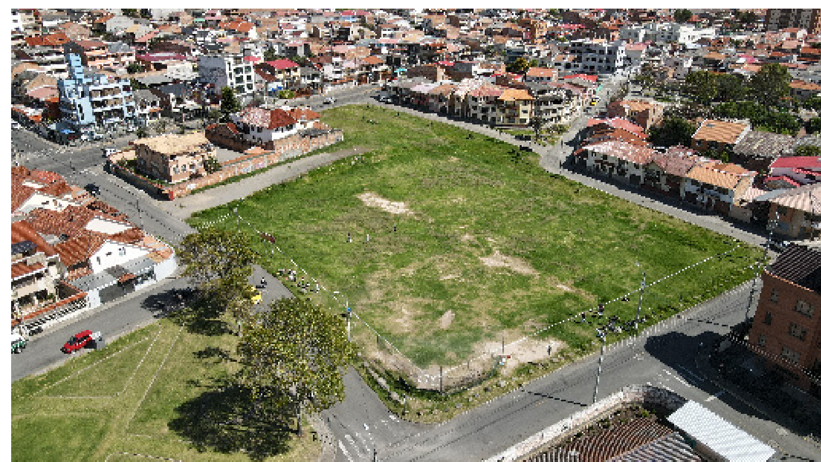
22 ESTADO ACTUAL DEL ESPACIO PUBLICO.
