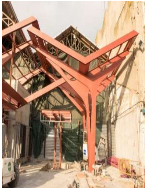
Figura 35: Materialidad de cubierta metal
