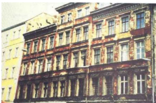
FIGURA 1.14: Ejemplo de edificio de vivienda antes de la renovación
