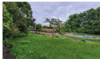
Muestra del deterioro de las piscinas. Fuente: Propia
