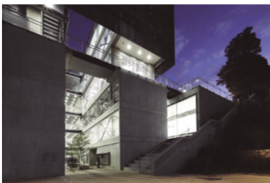
FIGURA 2.65: Muros de hormigón
