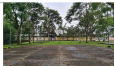
Muestra del deterioro de la cancha de básquet Fuente: Propia
