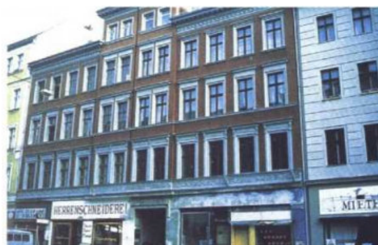
FIGURA 1.15: Ejemplo de edificio de vivienda después de la renovación
