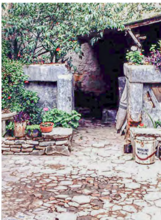
FIGURA 2.50: Centro Cultural El Prohibido, Segundo patio anterior a intervención. Fuente: Templo Arutam, s.f. Elaboración: Moscoso, 1996. https://www.facebook.com/photo/?fbid=2750226415210647&set=a.1783830648516900
