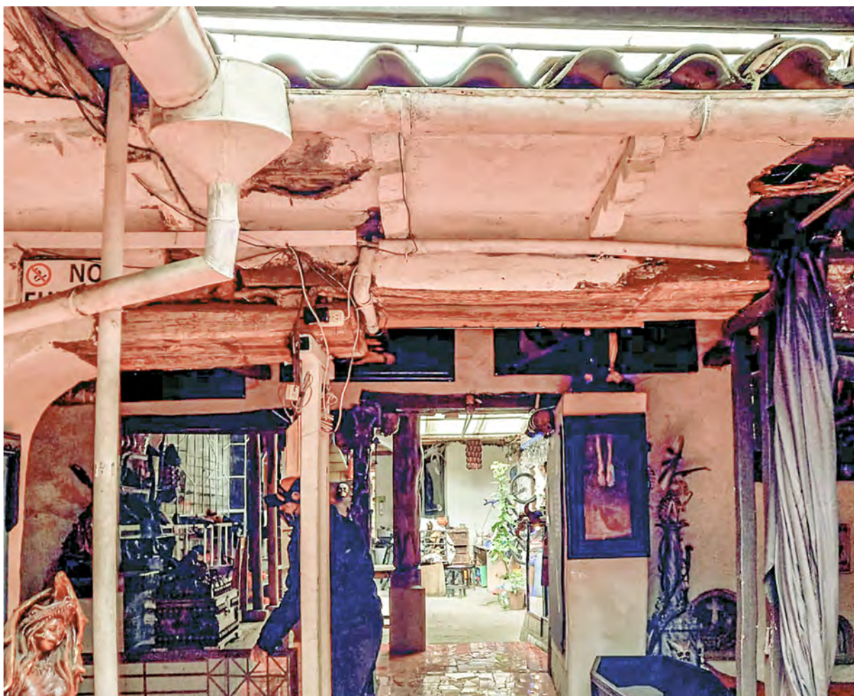
FIGURA 3.15: El Prohibido, estado actual: Inserción de sistema estructural elaborado por Moscoso (BC-24). Fuente: Moscoso, s.f. Elaboración: propia.
