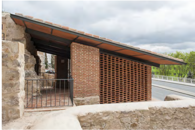
FIGURA 1.4: Convento de San Andrés en Salamanca, posterior a la intervención Fuente y elaboración: Sánchez, 2018. https://www.plataformaarquitectura.cl/cl/939467/restauracion-de-tenadas-y-pozo-de-nieve-del-convento-de-san-andres-sanchez-gil-arquitectos
