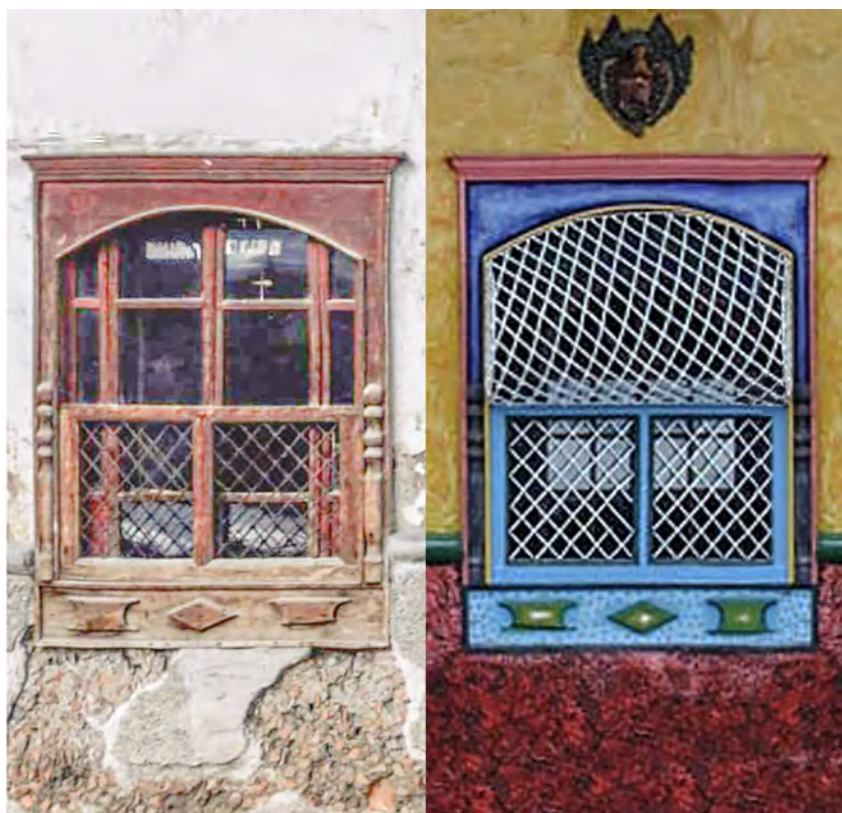
FIGURA 2.22: Ventanas Centro Cultural El Prohibido. Fuente: Moscoso, s.f. Elaboración: propia.
