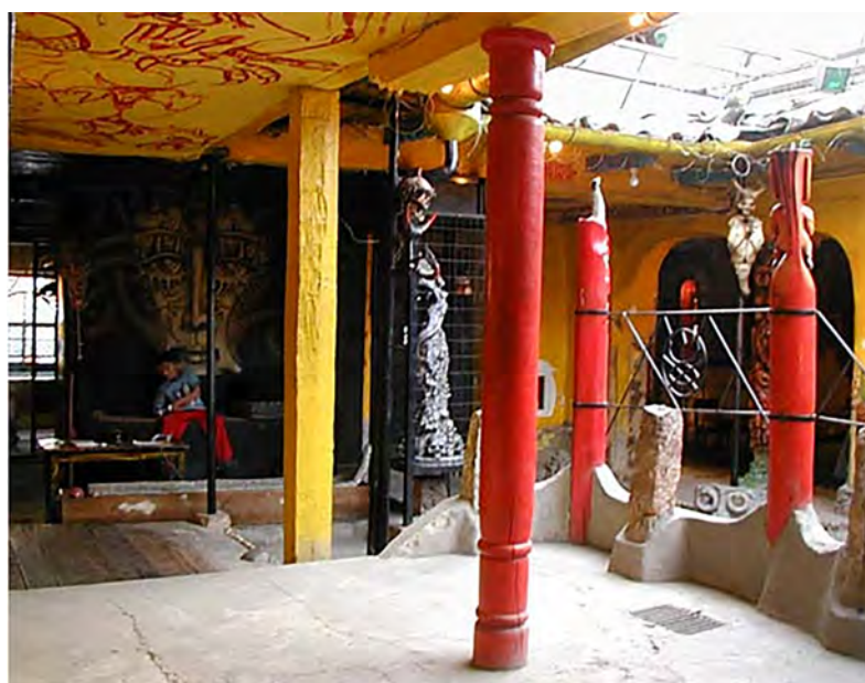
FIGURA 2.24: Columna interior transformada, Centro Cultural El Prohibido. Fuente y elaboración: Moscoso, 2004.
