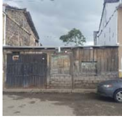
Fotografía 26. Tramo 3, Vivienda 4, Predio 004.
