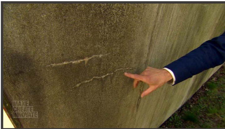
Fotografía 6. Estación de Salvavidas concreto reparado.
