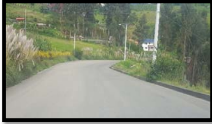
Fotografía 45. Vía Principal camino a Pichacay.
