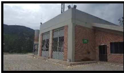
Fotografía 47. EBE, Central de generación de Electricidad con Biogás.
