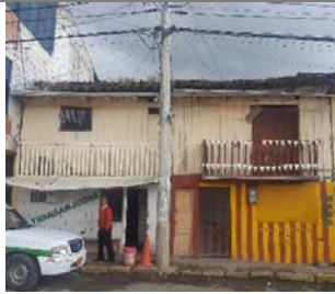
Fotografía 28. Tramo 3, Vivienda 6, Predio 006.
