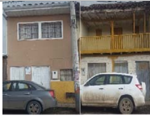
Fotografía 25. Tramo 3, Vivienda 3, Predio 003.
