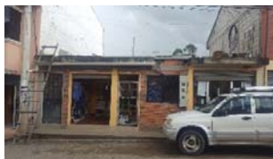
Fotografía 32. Tramo 3, Vivienda 10, Predio 014.
