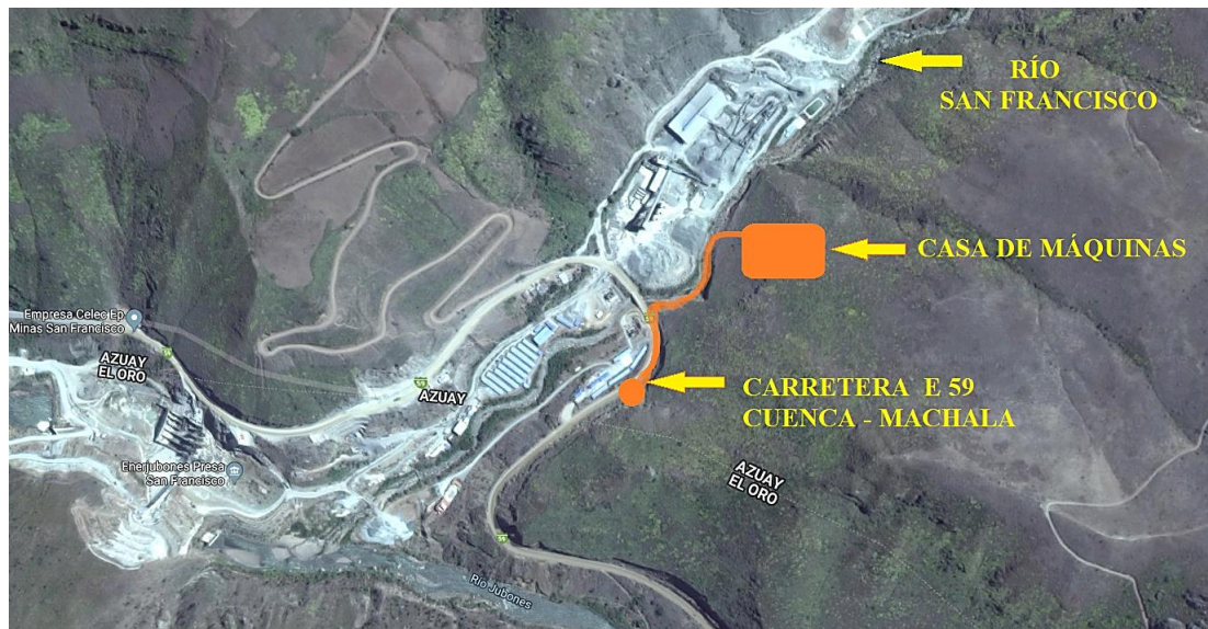
Figura 65. Vía de acceso del Proyecto San Francisco II hasta la Casa de Maquinas
