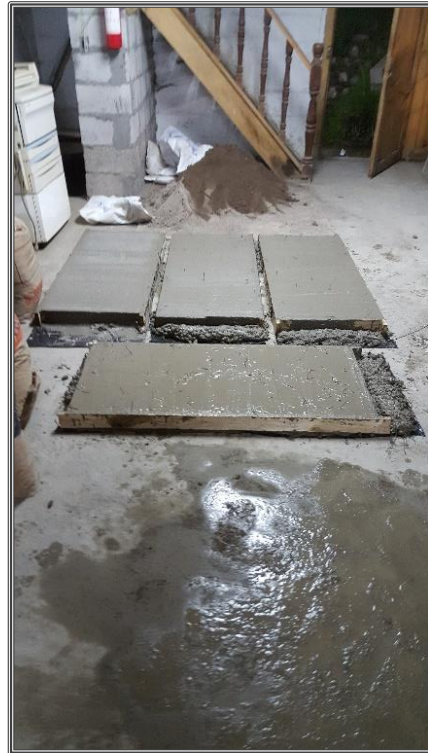
Fundición de las cuatro losas con distintas dosificaciones de fibras acabadas
