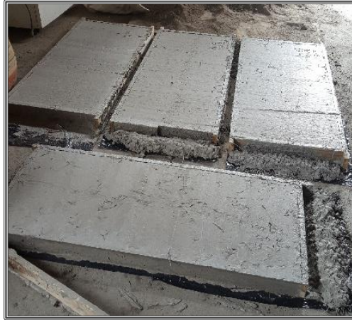
Desencofrado de losas para las pruebas
