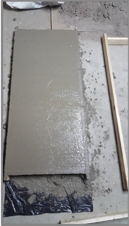
Elaboración de la primera losa
