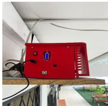
Figura 12: Estación móvil 6: Dispositivo instalado para la medición y registro de parámetros de calidad del aire
