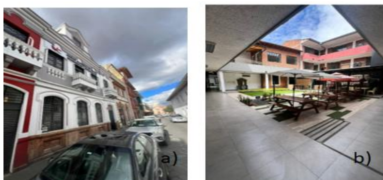
Figura 6: Fotografías de la Unidad Académica de Ciencias Económicas y Empresariales, a) área externa, b) área interna
