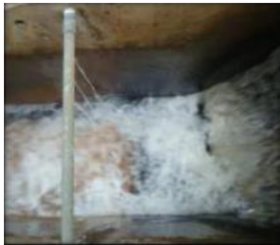
Figura 3.3 Mezcla de coagulante con el agua cruda. Fuente: Cortesía EMAPAL-EP
