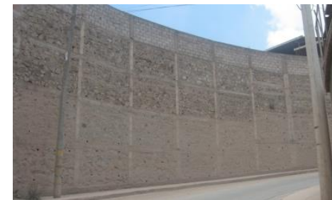
Imagen 81. Paredes de hormigón.
