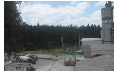
Imagen 80. Cubierta de las actuales industrias.
