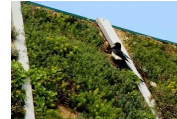
Imagen 56. Presencias de fauna en la fachada del Palacio de Congresos de Vitoria –Gasteiz.
