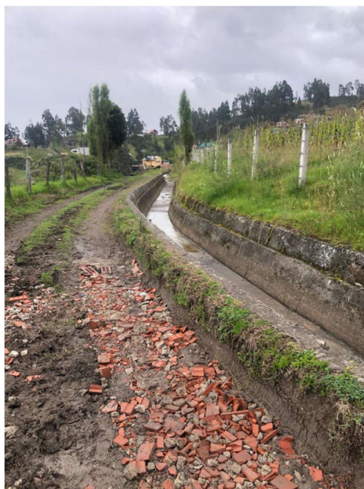
Figura 4. Tramo del canal principal de conducción
