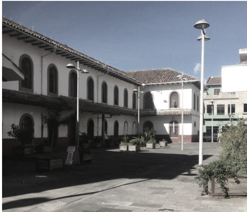
FIGURA 4.36: Estado actual al interior de la manzana
