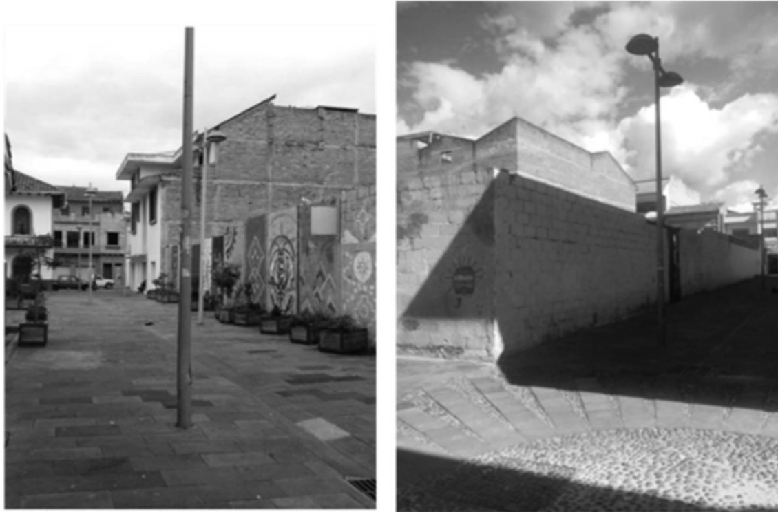
FIGURA 4.40: Estado actual al interior de la manzana
