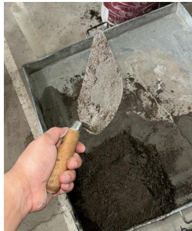
Figura 4 Mezcla de mortero
