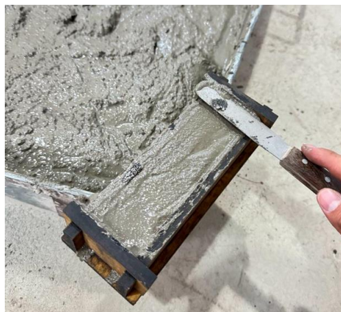
Figura 9 Mezcla para viguetas
