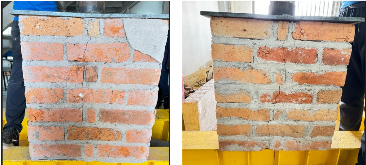
Figura 18 Paneles 5 min expuesto al horno (1lado enlucido)
