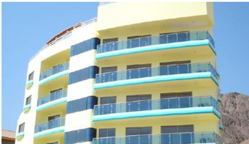
Imagen 2.2.4 Edificio inteligente bicentenario
