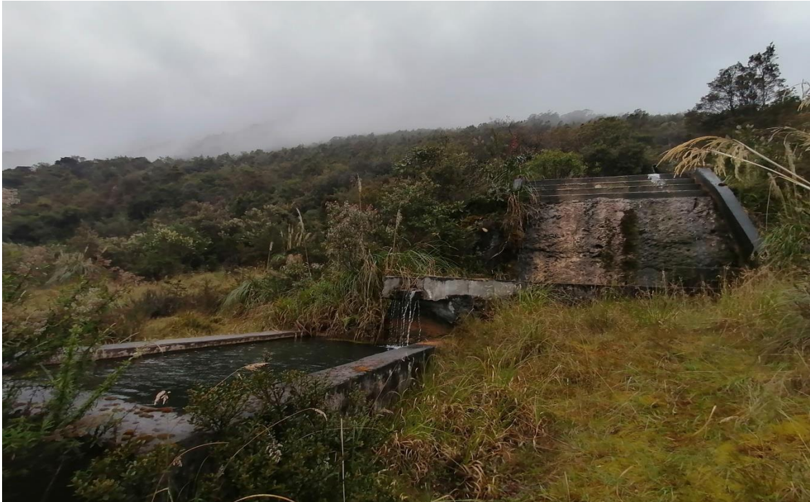
Figura 13: Piscina de captación y almacenamiento de agua en medio de la flora del lugar
