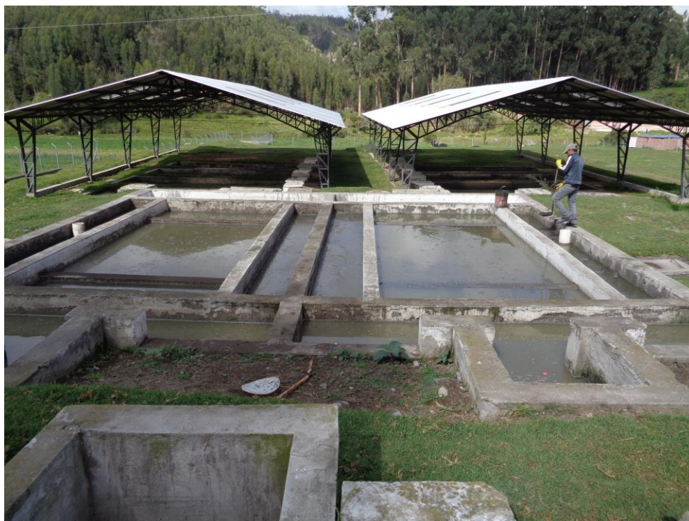
Vista Panorámica de PTAR – Libertad – Riobamba, Filtros y lechos
