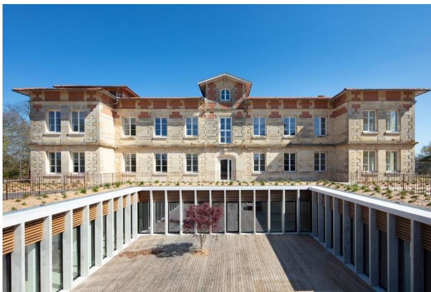
Imagen 3. Ampliación del refugio para mujeres – Francia
