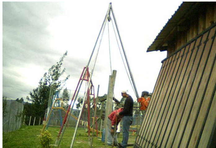
Foto 14: Ensayo SPT in situ con el equipo en operación, sector Nulti. Fuente propia.
