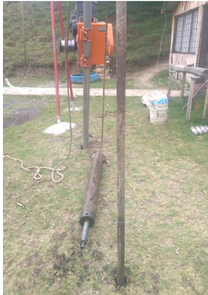
Foto 23: Primera perforación a la que se obtuvo una profundidad de 6.50 m. Fuente propia.
