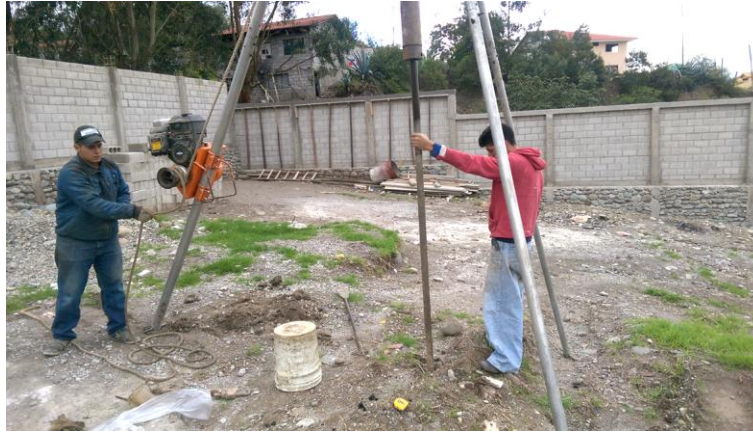
Foto 17: Equipo de perforación por percusión, de funcionamiento mecánico. Fuente propia.
