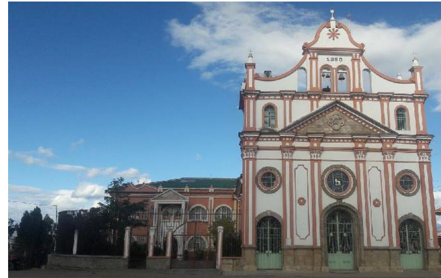
Foto N° 63: Panorámica 3 Fuente y Elaboración: Pedro L. Tierra A.
