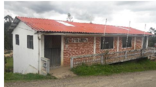
Foto N° 47: Casa comunal del barrio El Carmen de Sinincay Fuente y Elaboración: Pedro L. Tierra A.
