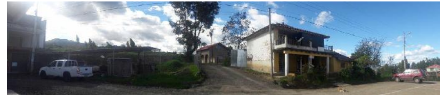
Foto N° 64: Panorámica 3 Fuente y Elaboración: Pedro L. Tierra A.
