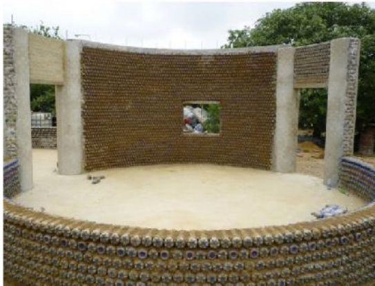
Foto N° 14: Paredes con botellas plásticas
