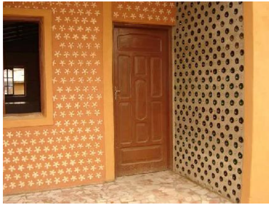
Foto N° 12: Paredes con botellas plásticas
