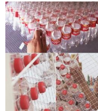
Foto N° 17: Techos falsos con material reciclado
