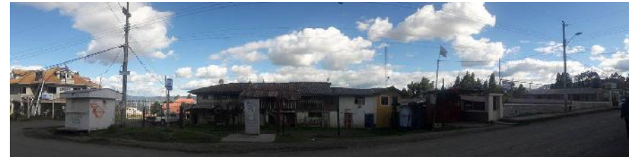
Foto N° 62: Panorámica 2 Fuente y Elaboración: Pedro L. Tierra A.
