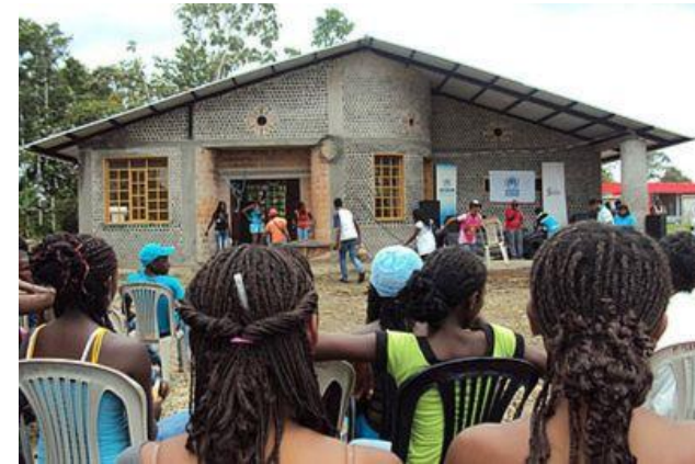
Foro N° 11: Paredes con botellas plásticas
