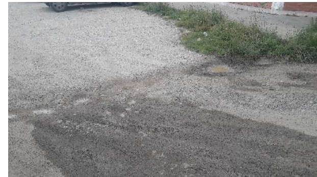
Foto N° 93: Panorámica 7 Fuente y Elaboración: Pedro L. Tierra A.
