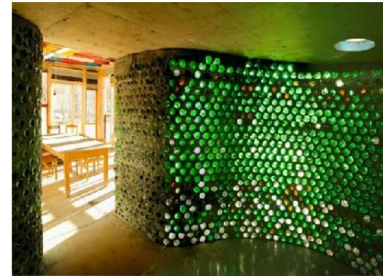
Foto N° 13: Paredes con botellas plásticas
