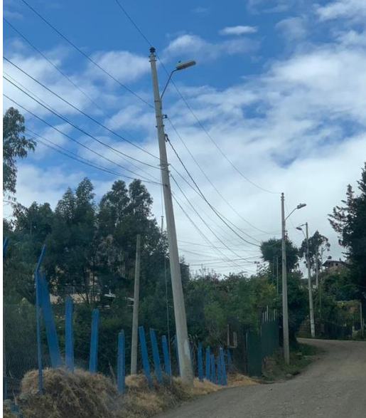
Ilustración 8: Fenómeno de la reptación presentes en las zonas de estudio Nulti y Paccha.
