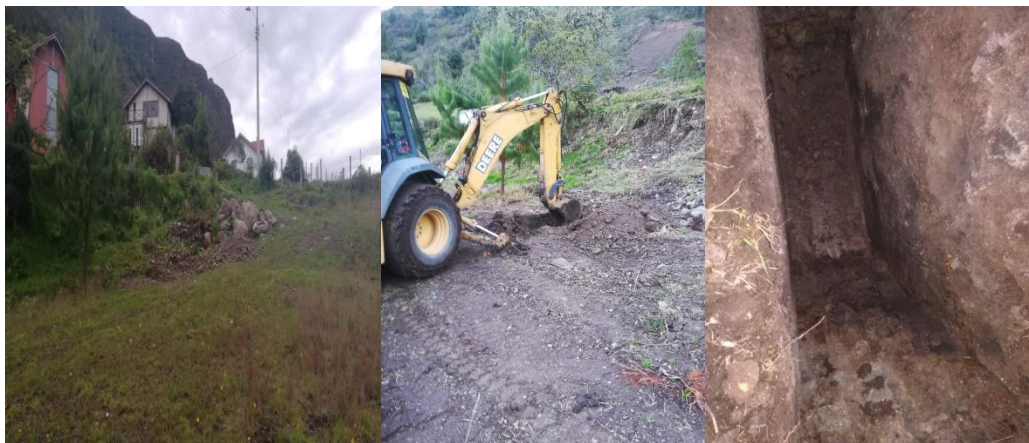
Ilustración 6: Extracción de la calicata en la Parroquia Paccha.
