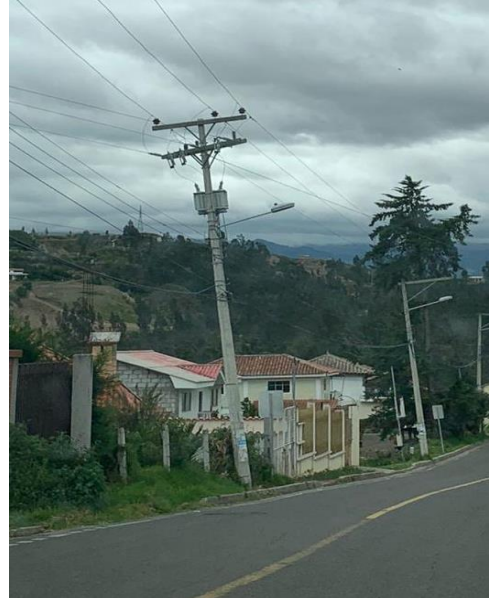
Ilustración 8: Fenómeno de la reptación presentes en las zonas de estudio Nulti y Paccha.
