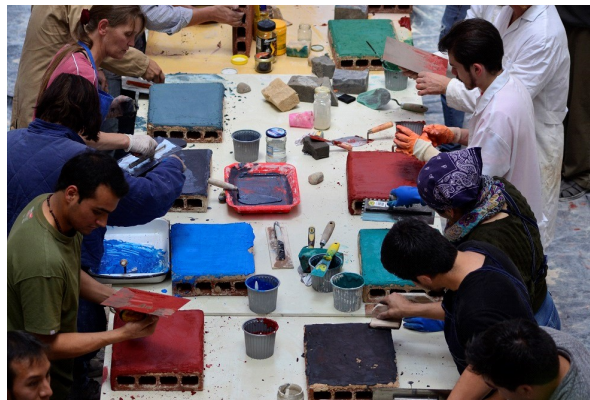
Imagen N. 7: Taller de recubrimiento impermeable de cal denominado Tadelakt, fotografía de Andrés Sánchez Torres.
