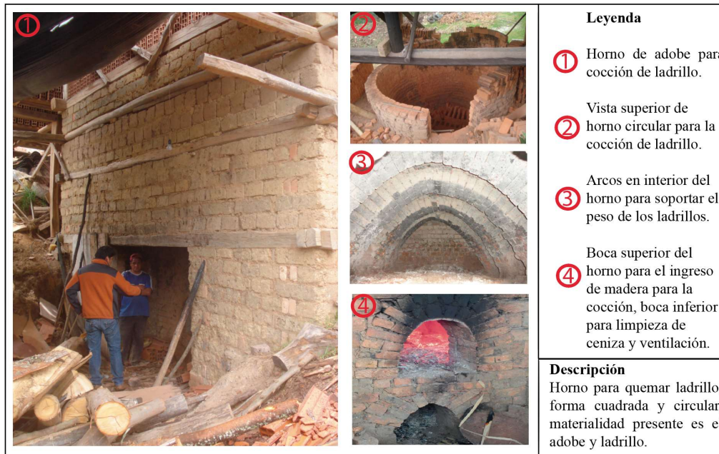
Imagen N. 18: Horno para la cocción de ladrillo, teja y semejantes.
