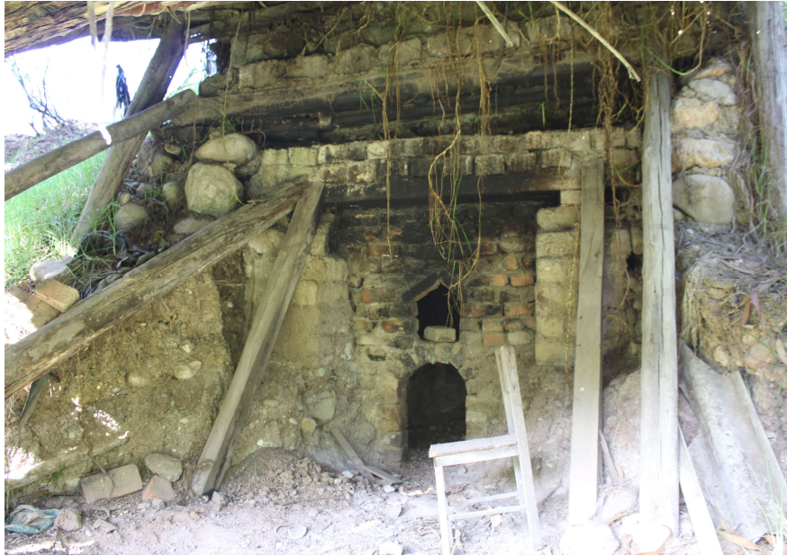
Fotografía N. 2: Vista frontal del horno de cal N.3.
