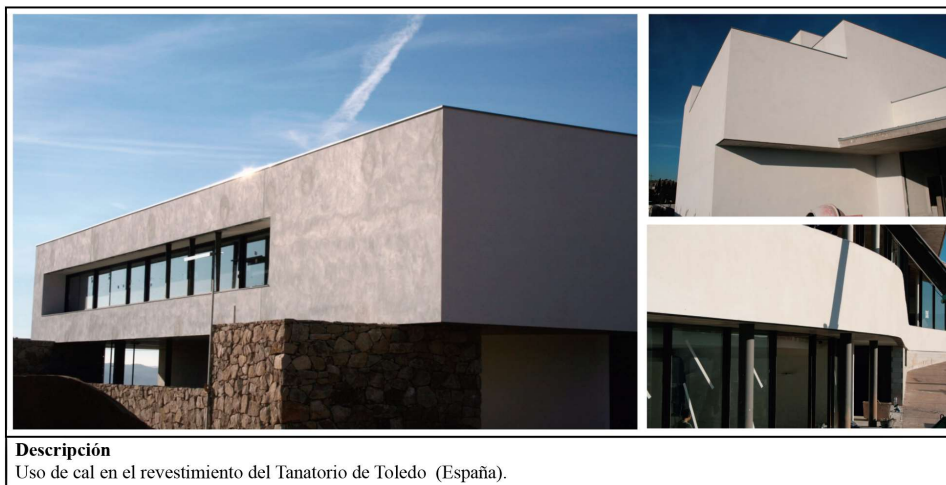
Imagen N. 2: Edificio del Tanatorio de Toledo con revestimiento de cal.
