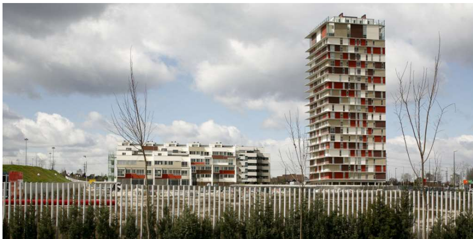
Imagen N. 1: Viviendas Panorama Arq. Jerónimo Junquera.
