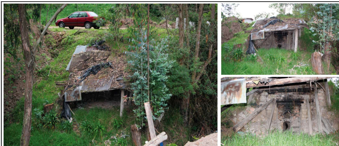
Descripción Estado actual del horno, presenta un abandono y un deterioro generado por las inclemencias climáticas y la vegetación.
