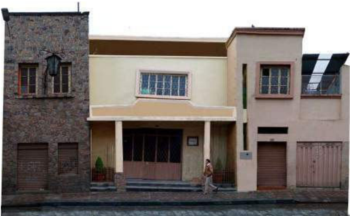
FIGURA 3.16: Estado actual de la edificación 36 (Calle Juan Montalvo) Elaboración: Pablo Andrés Toral B.
