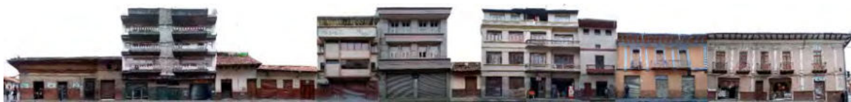
FIGURA 2.42: Tramo de la calle Juan Montalvo.
