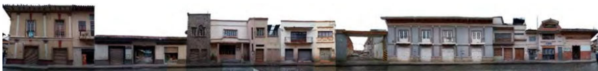
FIGURA 2.39: Tramo de la calle Mariscal Sucre.
