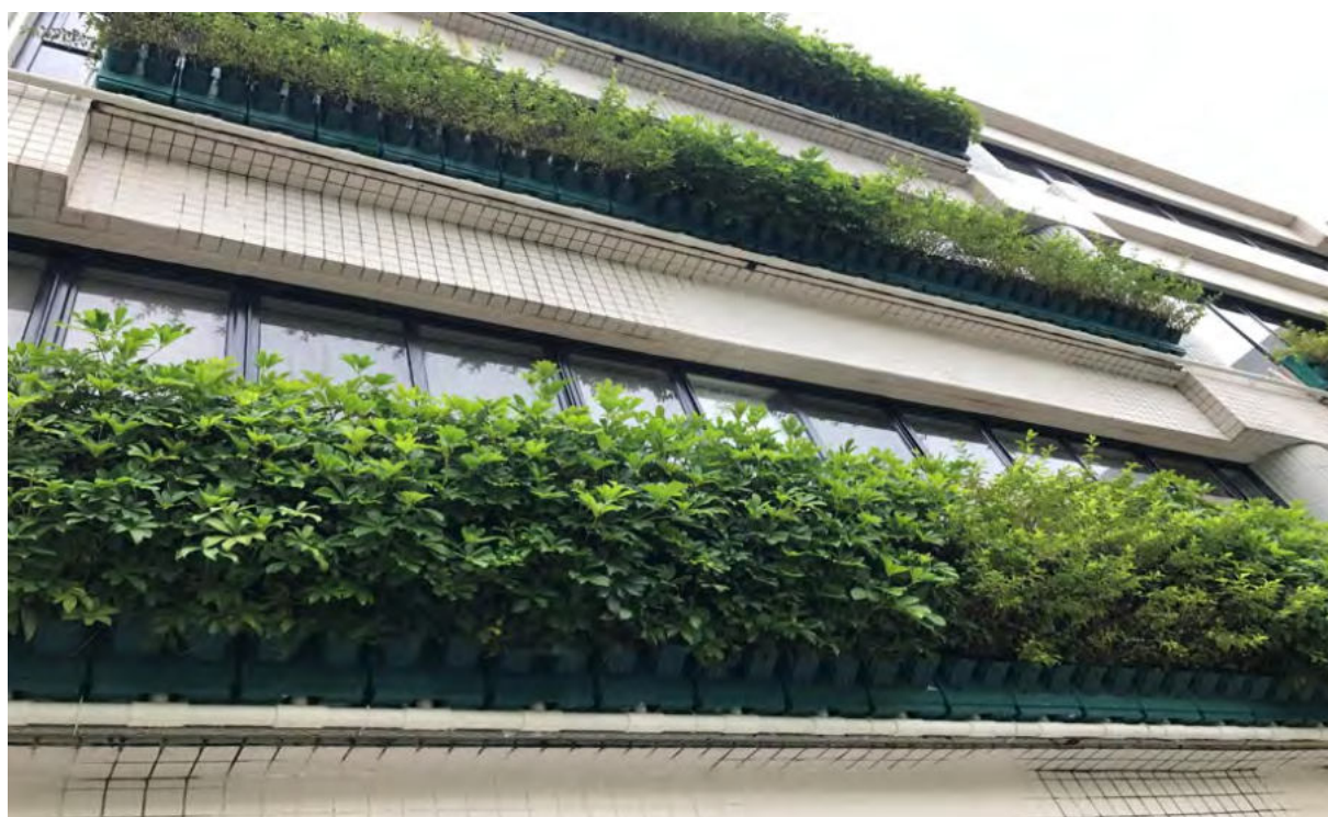
FIGURA 1.20: Aplicación de una fachada con panel vegetado de celda de resinas plásticas.
