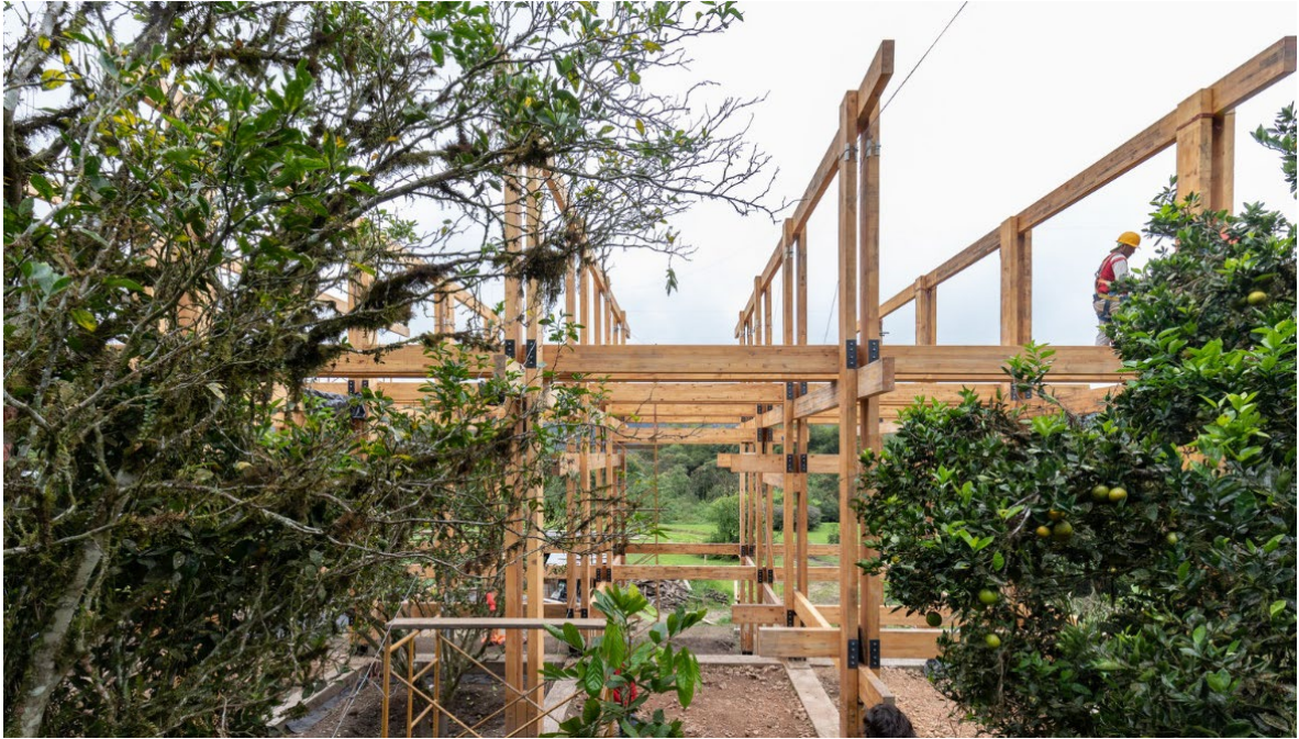
Figura 21 Sistema Estructural Casa Pitaya, Mindo
