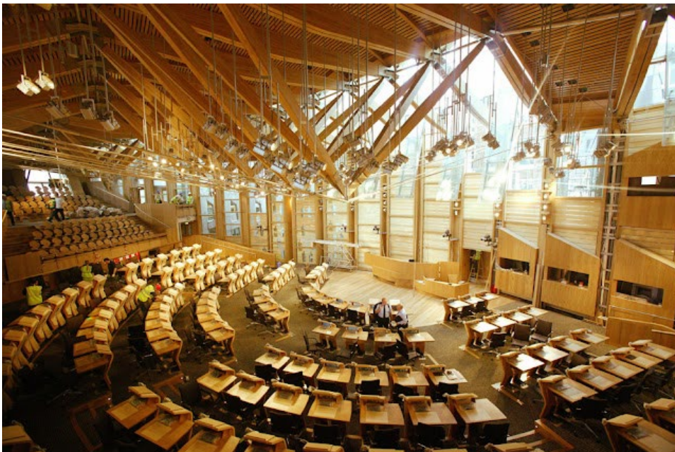
Figura 13 Cubierta en madera laminada del Parlamento de Escocia.
