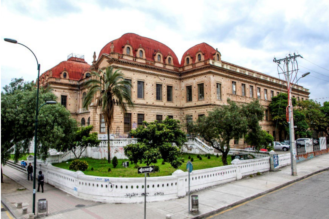
Figura 17 Fachada Colegio Benigno Malo
