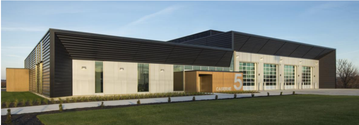
Figura 49. Respuesta formal de la Estación de Bomberos #5 de Pintendre, Canadá Fuente: (Architectes, 2016)
