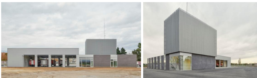
Figura 22. Fachada exterior del parque de bomberos N°4 de Zaragoza, España.
