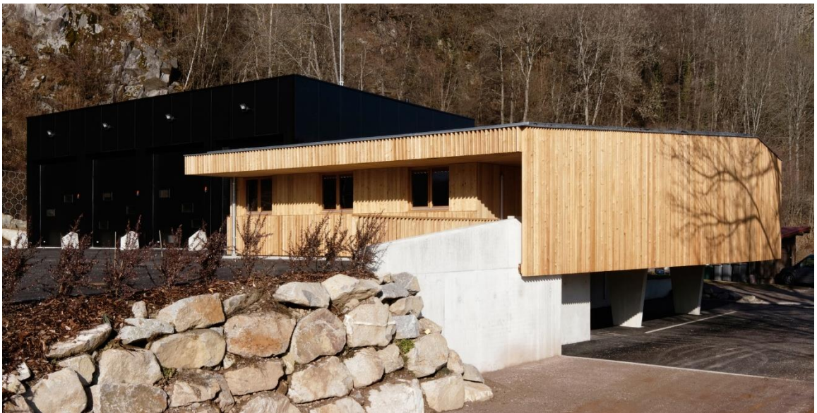
Figura 73. Fachada exterior de la estación de Bomberos de Metzeral, Francia Fuente: (Picquet, 2017)
