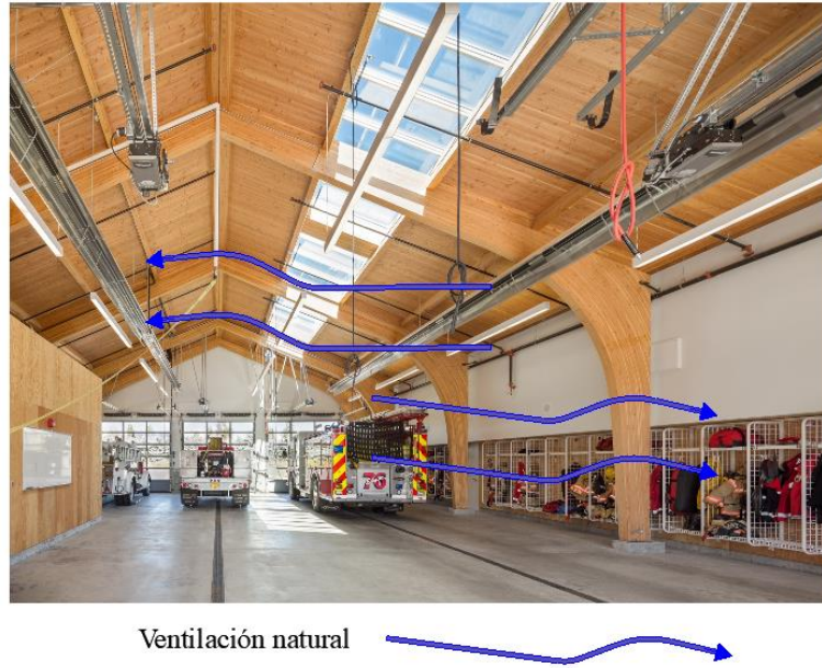
Figura 70. Ventilación natural de la estación de Bomberos 76 de Greshman, Estados Unidos Fuente: (Eddy, 2015)
