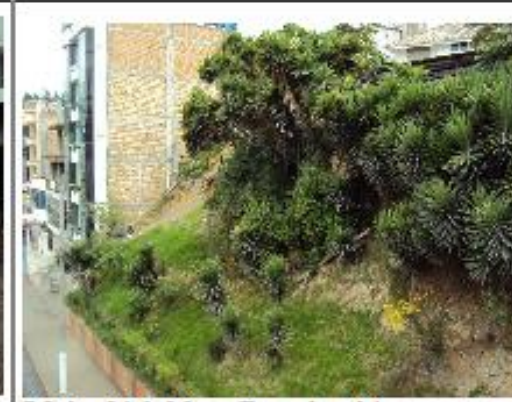
7.2 Av. 24 de Mayo (Paso elevado)
