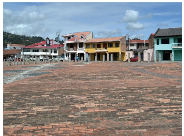
FIGURA 3.2: Falta de mantenimiento. Elaborado: Autor
