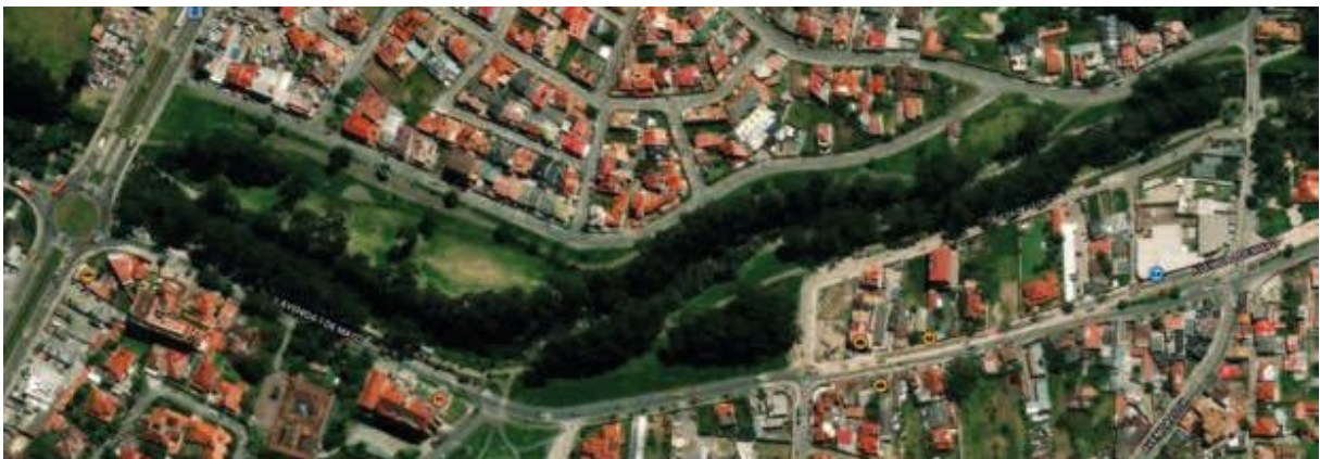
FIGURA 3.47: Vista aérea. Fuente: Google Earth
