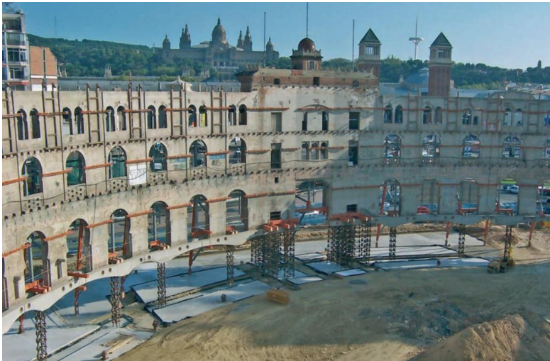
Figura 88: Conservación de fachada
