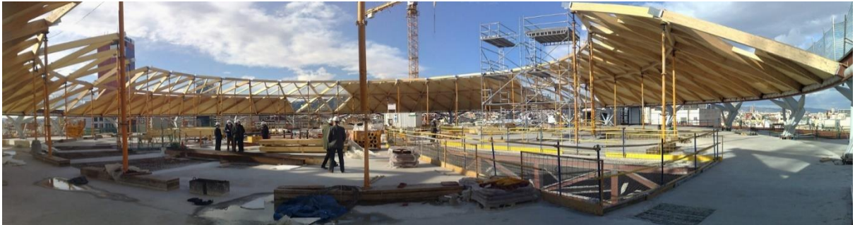
Figura 101: Construcción de cubierta
