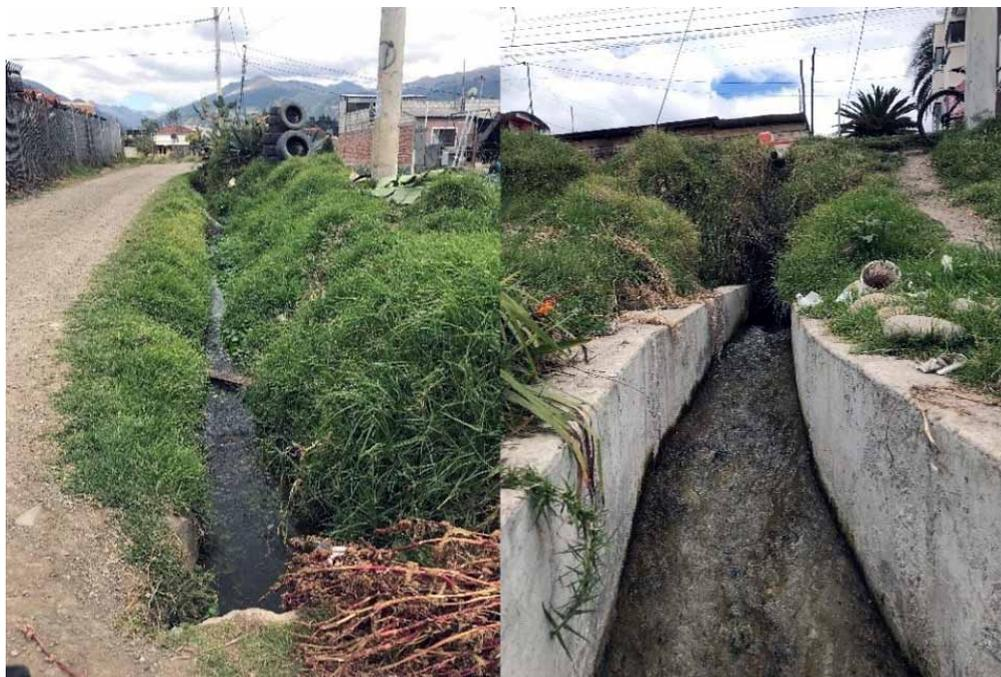
FIGURA 2.18: Canal de riego natural y canal de riego de hormigón
