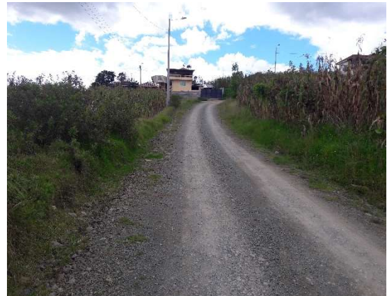
Ilustración 5 Falta de sistema de alcantarillado en calle sin nombre 10. Fuente: Autores.
