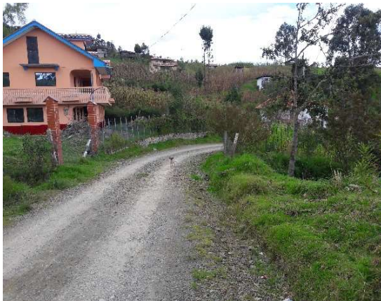
Ilustración 6: Falta de sistema de alcantarillado sanitario y pluvial en calle sin nombre 6. Fuente: Autores.
