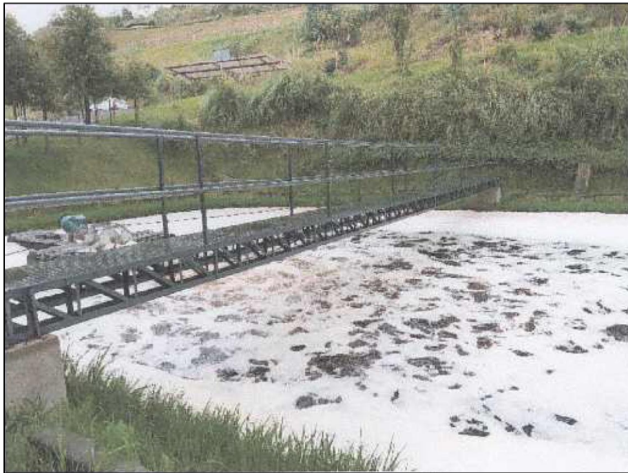
Figura 27: Laguna de aireación de lixiviados.
