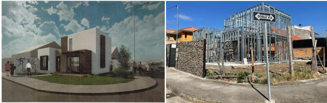
Figura 109: Vivienda con Steel Framing
