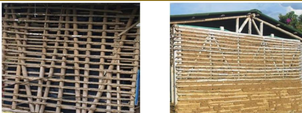
Figura 5: Proceso de construcción de muros en bahareque embutido.
