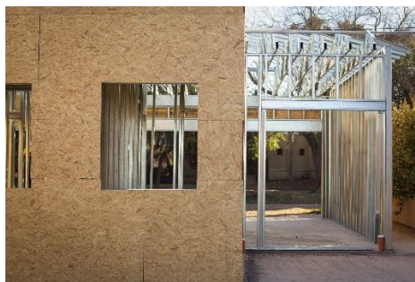
Figura 64: Tablero de OSB aplicado al Steel Framing Fuente: (HIPERSECO, 2023)
