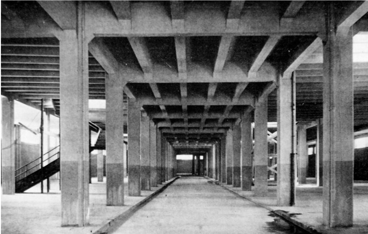
Figura 34: Estructura de hormigón armado del Mercado de frutas y verduras de Legazpi Fuente: S/N. (1955).
