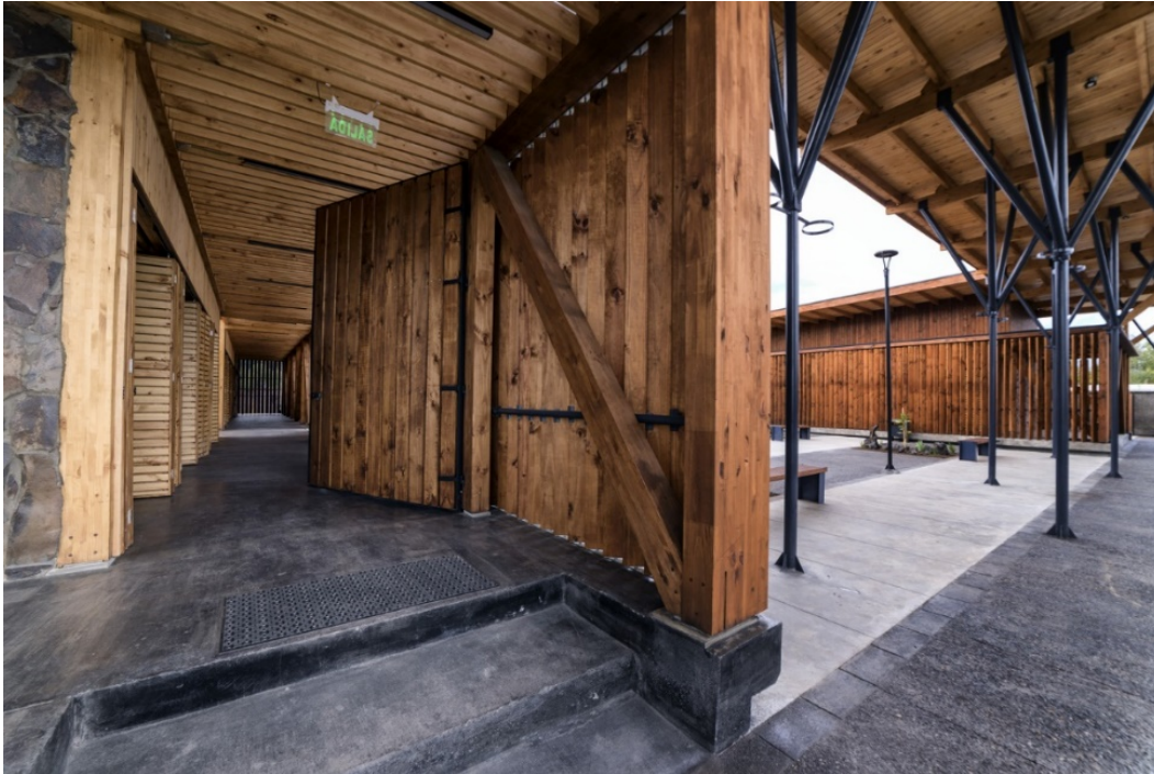
Figura 18: Estructura de madera del Mercado Curacautín Fuente: Astaburuaga, M. (2020).
