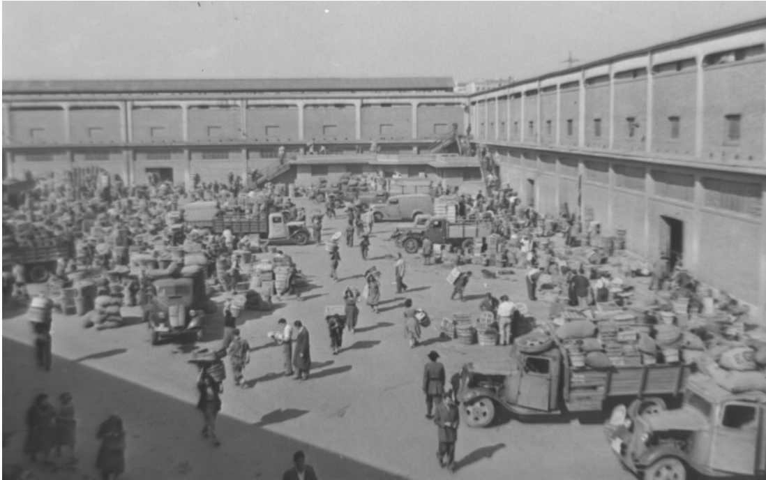
Figura 30: Patio interior (o plaza) del Mercado de frutas y verduras de Legazpi, rebotante de actividad de carga y descarga, tratos y otros negocios. Fuente: S/N. (1955).
