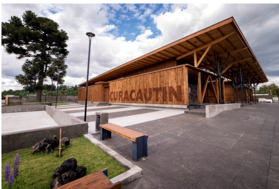
Figura 14: Estado Actual del Mercado Curacautín Fuente: Astaburuaga, M. (2020).
