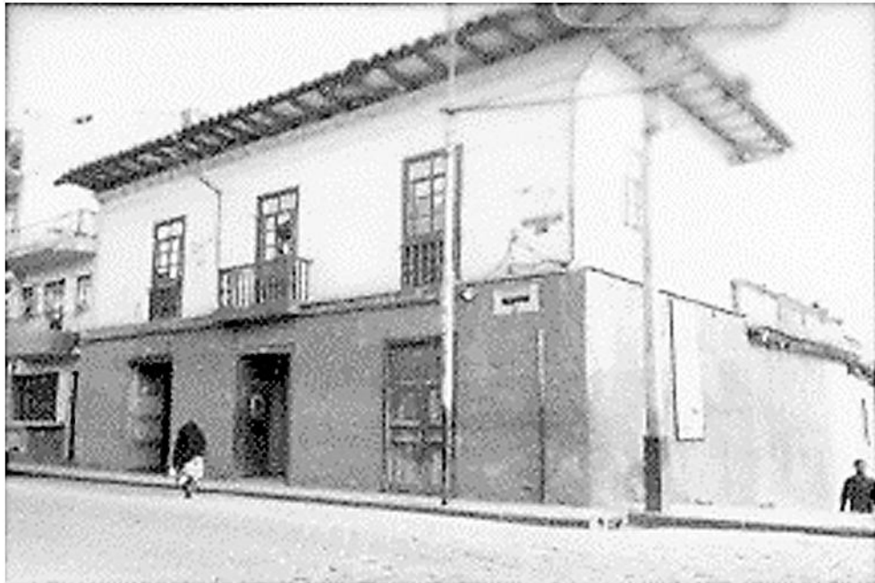
FIGURA 2.2: Fachada de vivienda año 1983
