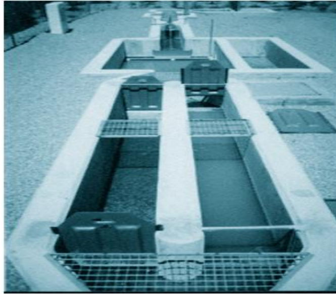
Esquema 9: Desarenador de flujo horizontal
