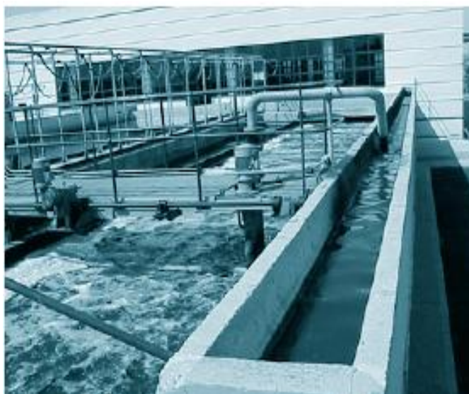
Esquema 12: Desengrasador aireado
