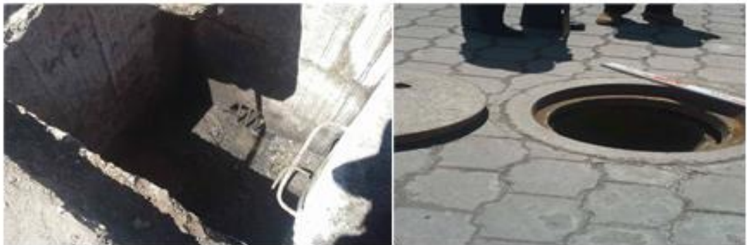
Fotografía 2: Pozos de revisión del sistema de alcantarillado actual.
