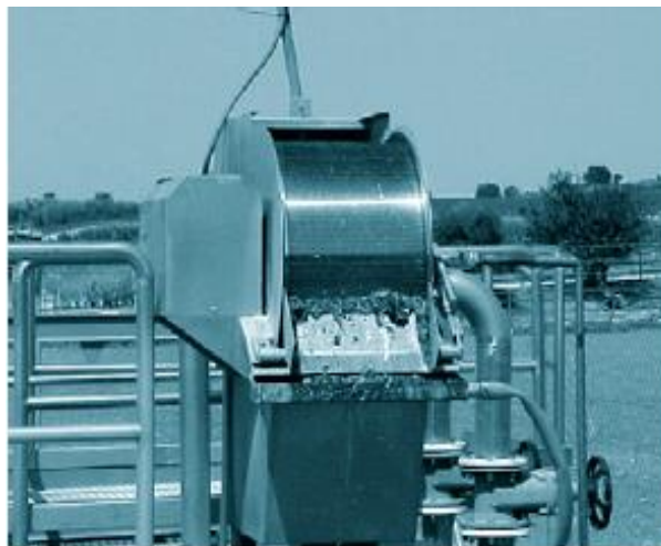
Esquema 8: Tamiz rotativo
