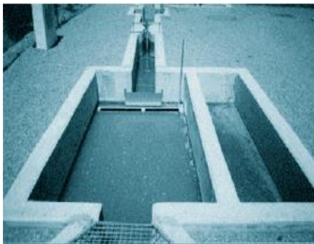
Esquema 11: Desengrasador estático
