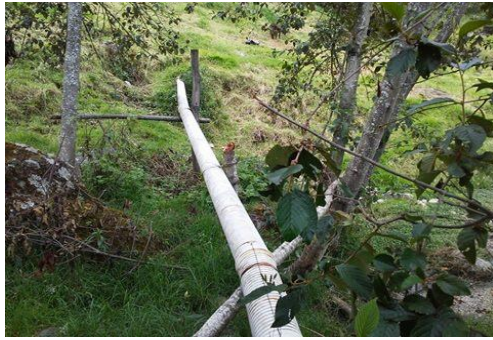
Estado actual de la descarga
