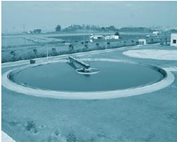
Esquema 13: Sedimentador primario
