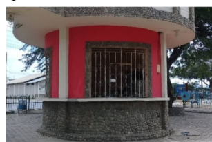
FIGURA 2.103: Foto 104. Área del Bar. Fuente: Propia
