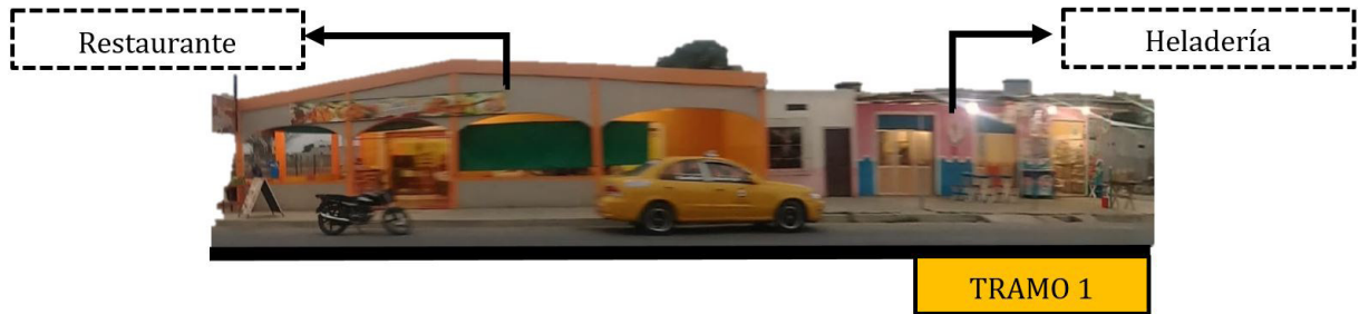
FIGURA 2.67: Foto 68. Tramo #1 "Parque San Gregorio". Fuente: Propia
