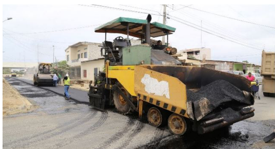
FIGURA 2.35: Foto 36. Asfaltado de vías. Fuente: Diario El Orito
