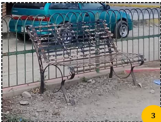
FIGURA 2.43: Foto 44. Mobiliario de descanso en mal estado. Fuente: Propia
