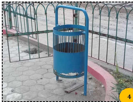
FIGURA 2.44: Foto 45. Basurero en mal estado. Fuente: Propia
