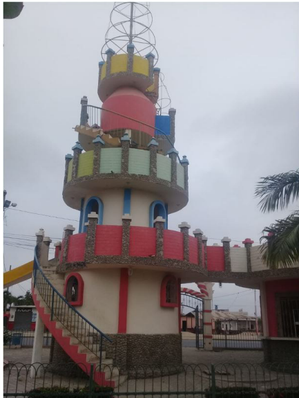
FIGURA 2.106: Foto 107 Estructura cerrada del mirador. Fuente: Propia
