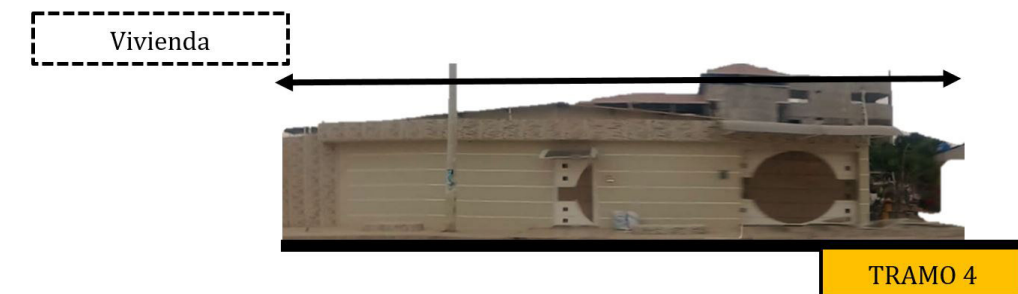
FIGURA 2.70: Foto 71. Tramo #4 "Parque San Gregorio". Fuente: Propia
