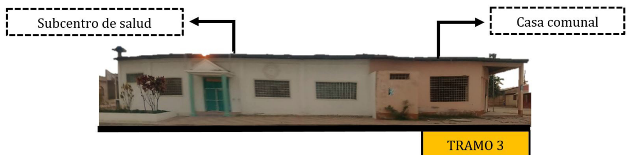
FIGURA 2.69: Foto 70. Tramo #3 "Parque San Gregorio". Fuente: Propia
