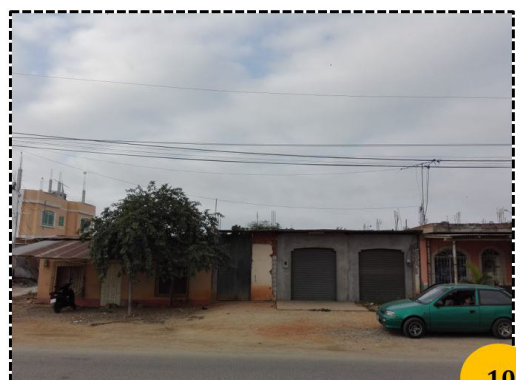
FIGURA 2.32: Foto 33. Inexistencia de veredas. Fuente: Propia
