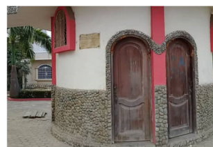
FIGURA 2.102: Foto 103. Baterías sanitarias. Fuente: Propia
