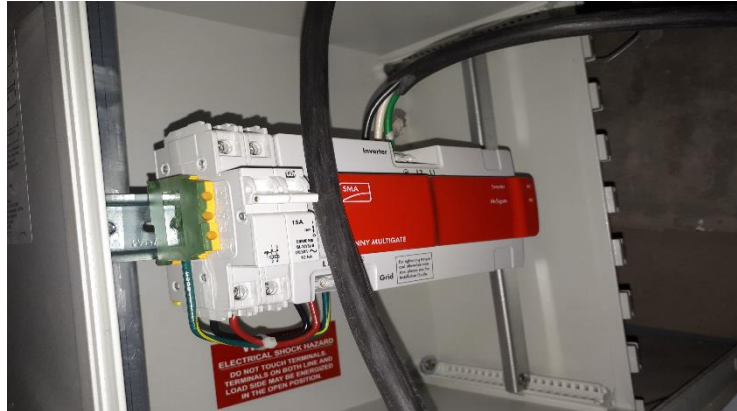
Figura 27. Conexión de Sunny Multigate US . Fuente : (Autores)
