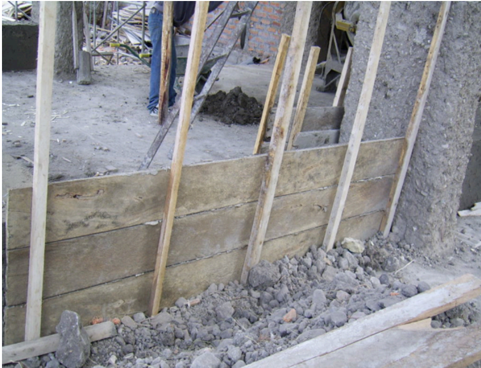
Foto N° 93: Encofrado recto de madera para antepecho de tapial en planta baja.
