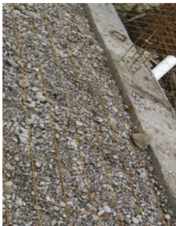
Foto N° 56 – Foto N° 57: Colocación de malla electrosoldada tipo Armex R-64, sobre replantillo emporado.
