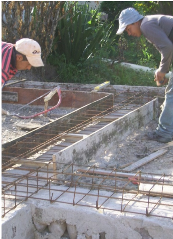
Foto N° 52: Encofrado recto para cadenas de hierro a nivel = +/- 0,00.
