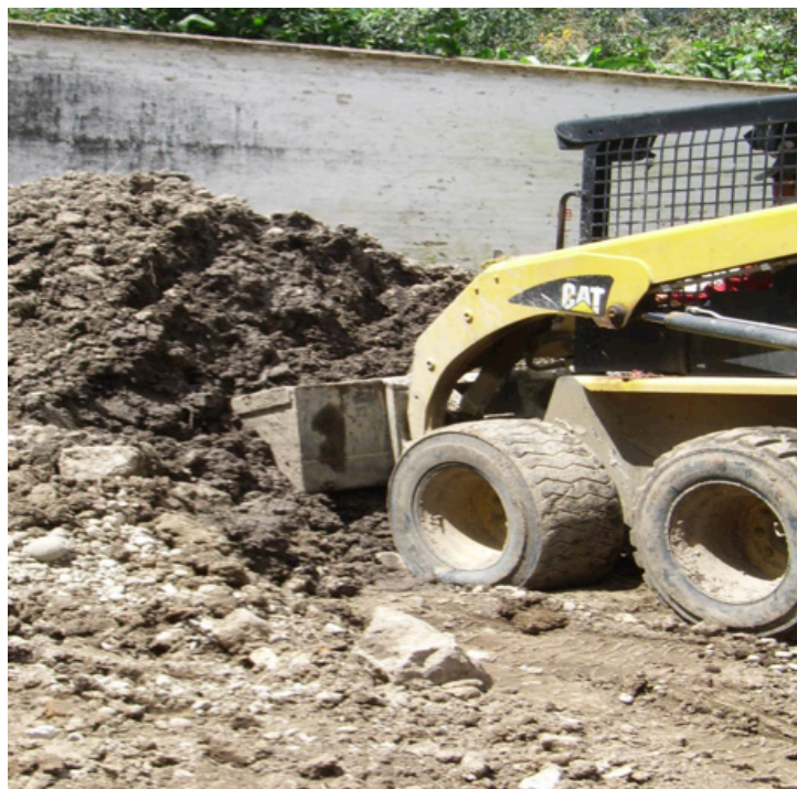
Foto N° 30: Desalajo de material saturado por aguas subterráneas.
