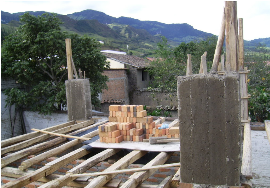
Foto N° 75: Mampostería de tapial vista de planta baja y planta alta.
