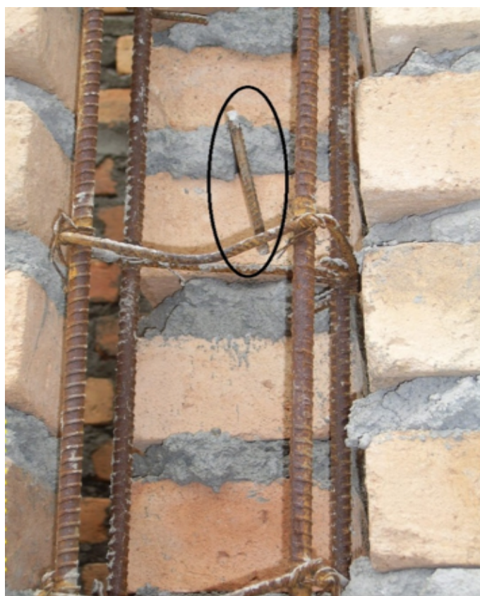
Foto N° 66: Chicotes de hierro para mampostería de ladrillo.
