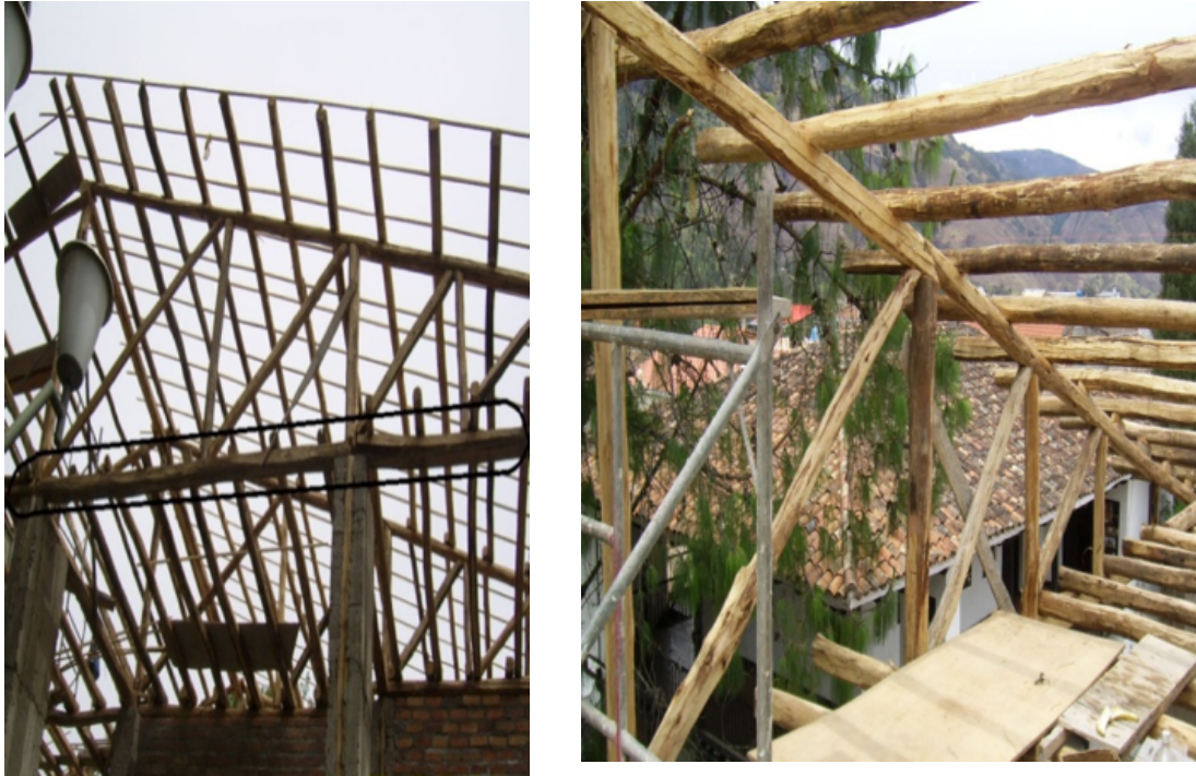
Foto N° 83: Estructura de cubierta y cubierta en teja artesanal.
