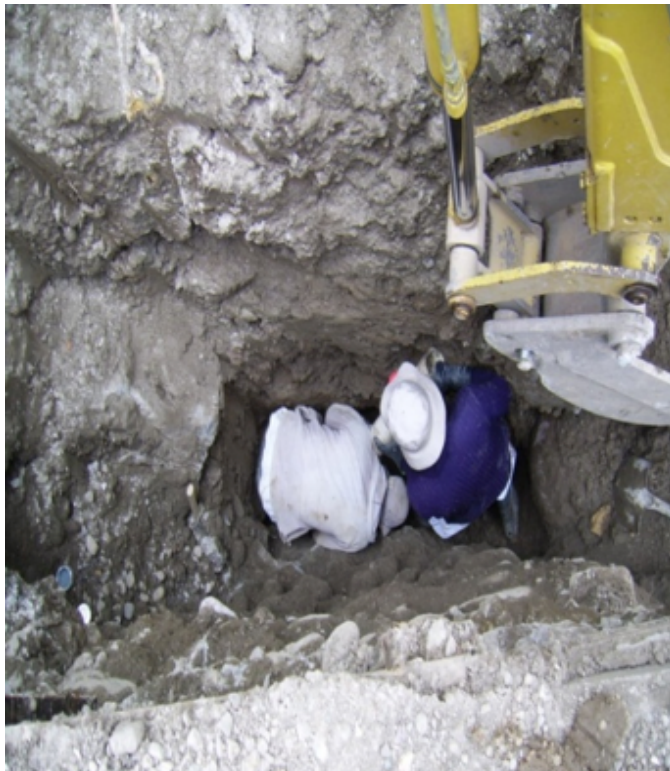
Foto N° 18: Excavación manual profunda para cimentación de obra.
