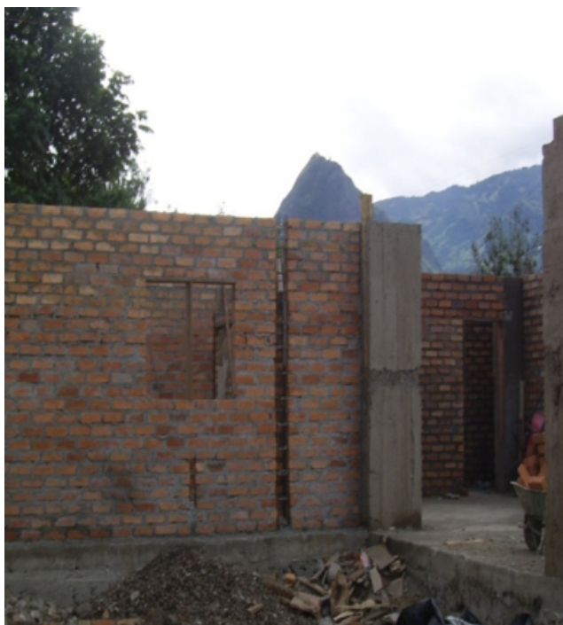
Foto N° 69: Armado de dinteles de puertas en mampostería de ladrillo.
