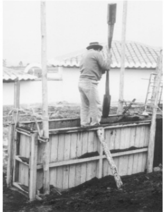
Imagen N° 9 y N° 10 y N° 11: Construcción de muro de tapia utilizando un pisón de dos cabezas empleado en Ecuador (Minke 2001).
