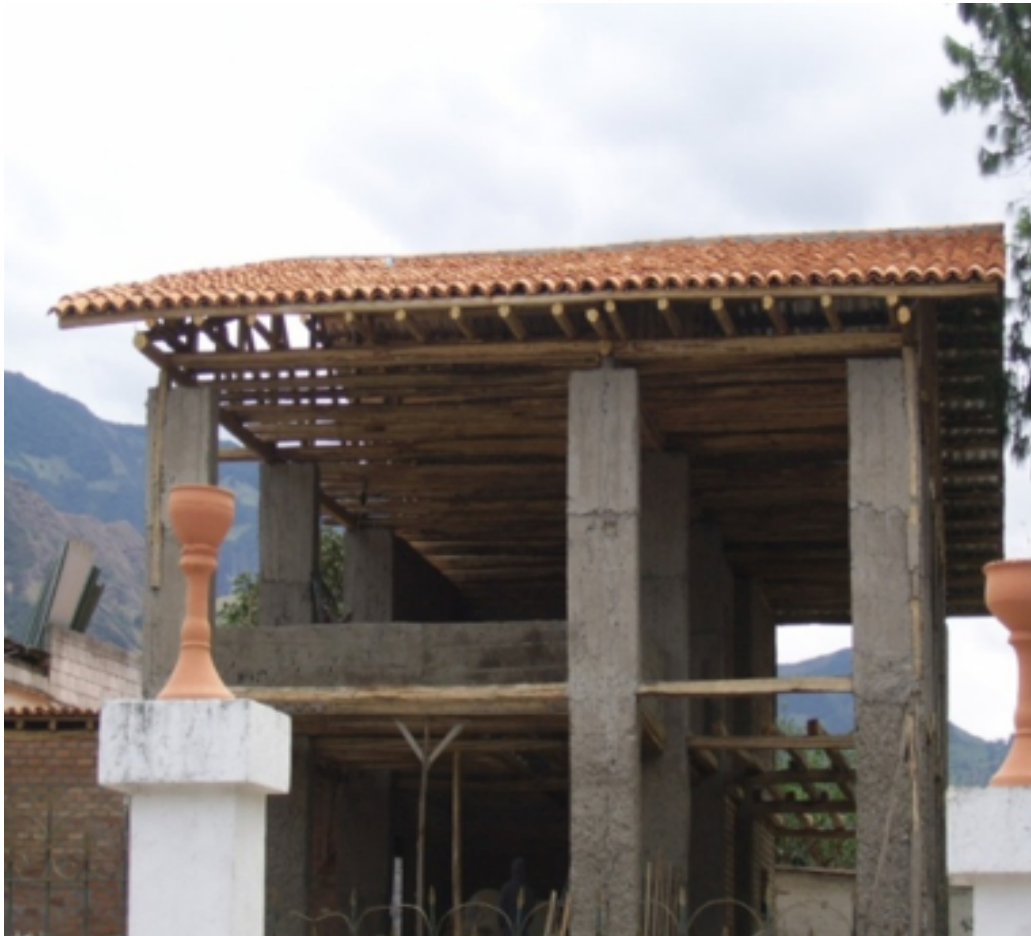
Foto N° 88: Detalle de revestimiento de cubierta en teja (tapa y canal).
