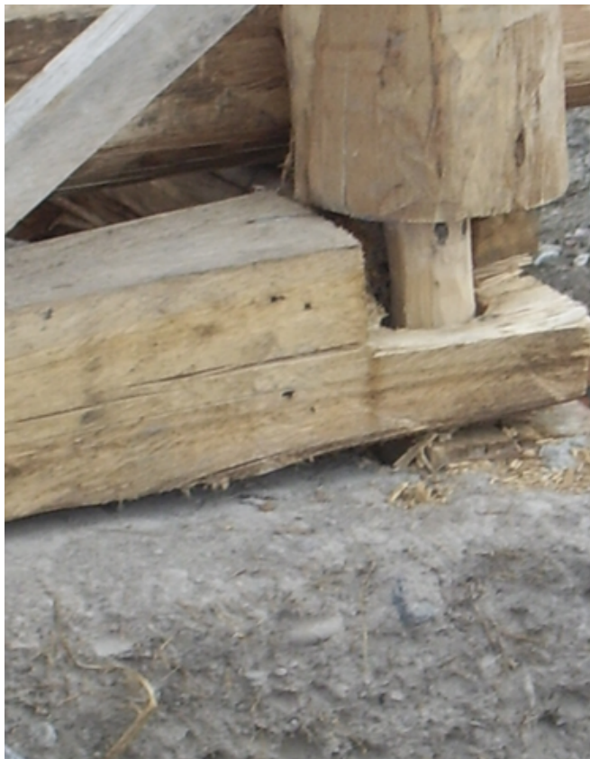
Foto N° 73: Encofrado de madera para mampostería de tapial en primera planta alta.
