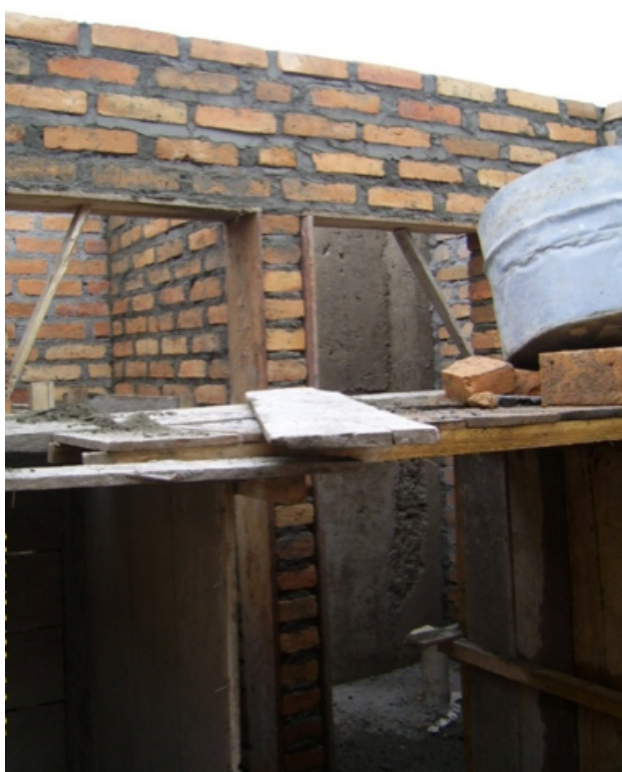
Foto N° 69: Armado de dinteles de puertas en mampostería de ladrillo.
