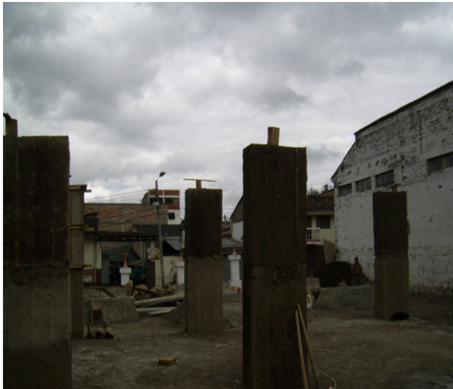
Foto N° 64: Mampostería de tapial que cubren las columnas de madera. 16 x 16 centímetros.
