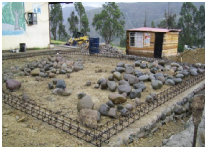
Foto N° 6: Detalle de armado de hierro para cadena de amarre.
