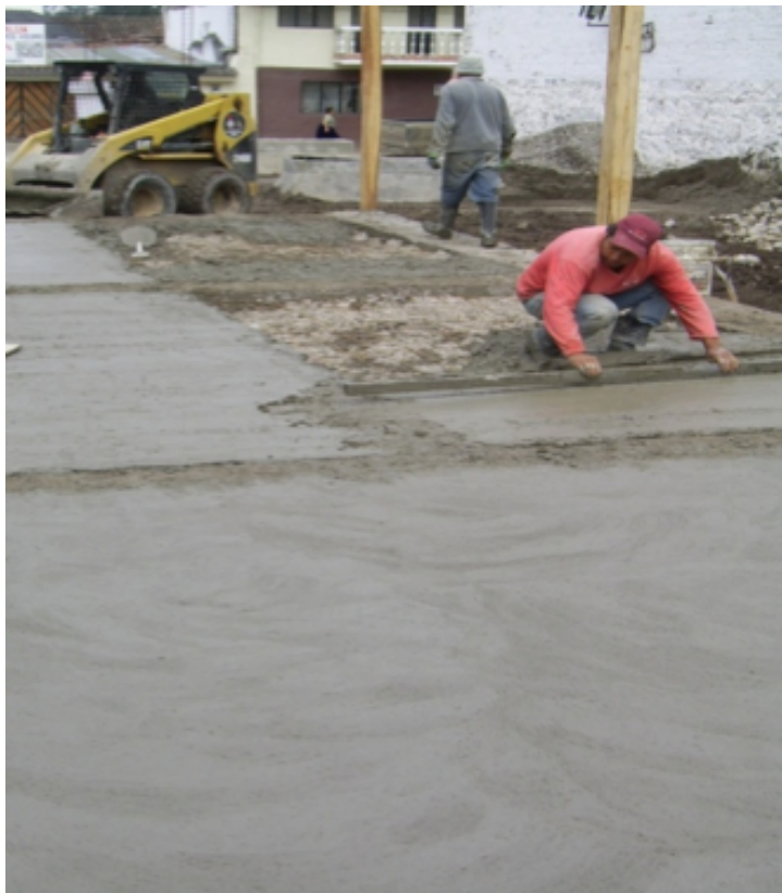
Foto N° 59: Chapa de compresión fundida por paños, con hormigón de 210 kg/cm 2 .
