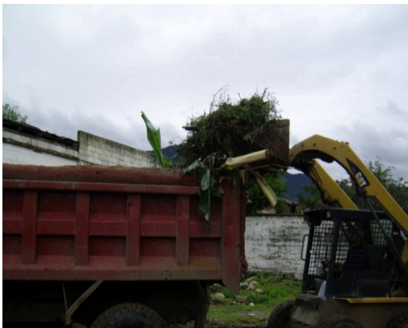
Foto N° 15: Desalojo de escombros y de capa vegetal para iniciar con la obra.
