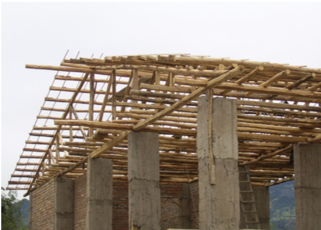
Foto N° 81: Armado de estructura de cubierta, vigas perimetrales de 16 x 16 cm.
