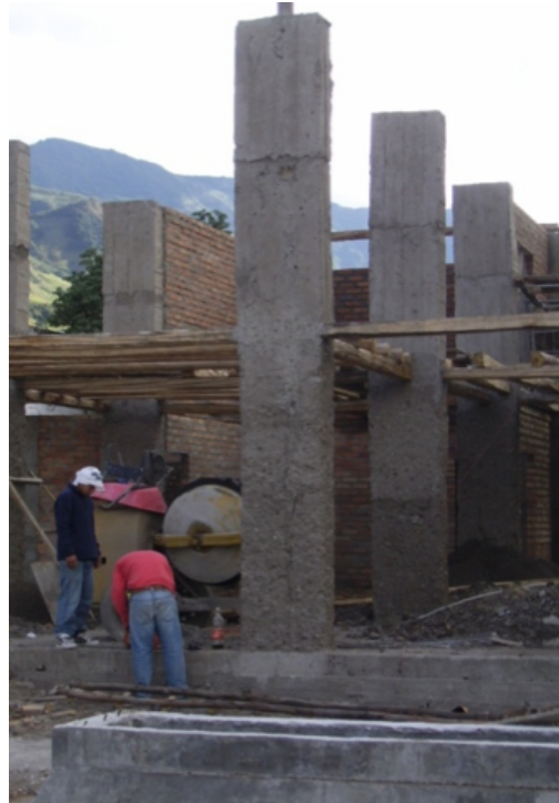
Foto N° 81: Armado de estructura de cubierta, vigas perimetrales de 16 x 16 cm.
