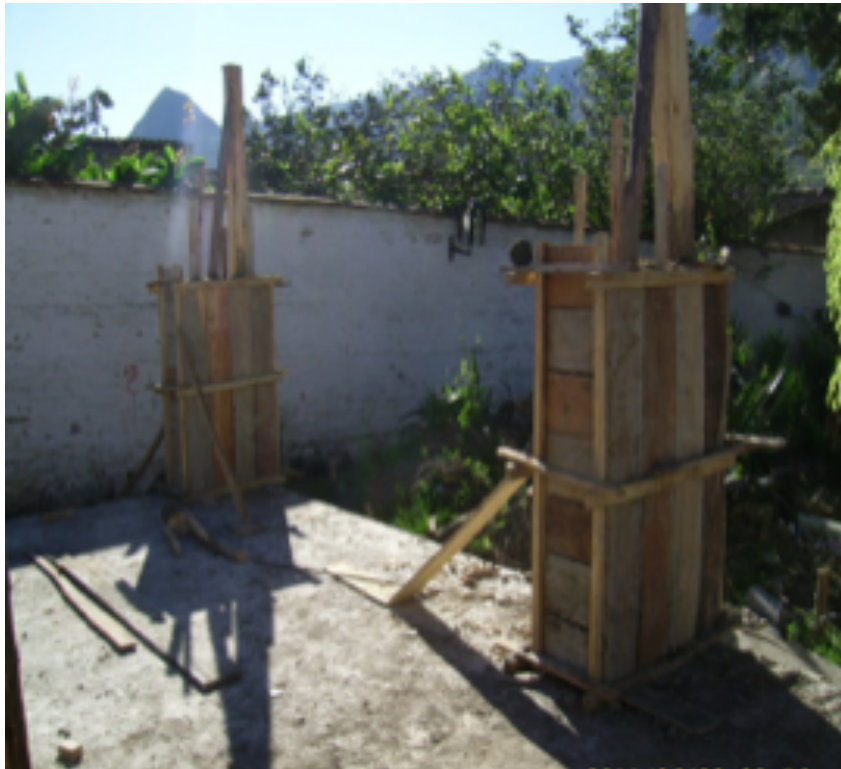
Foto N° 11: Detalle del encofrado de madera para armado de muros de tapial en obra.
