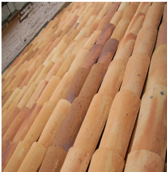
Foto N° 88: Detalle de revestimiento de cubierta en teja (tapa y canal).
