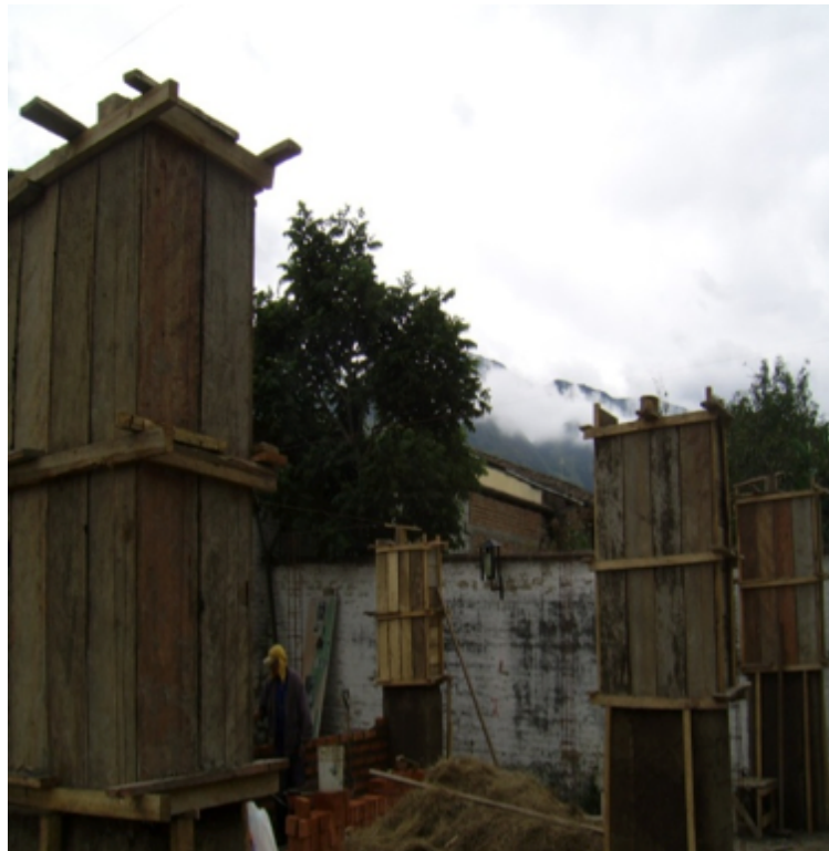
Foto N° 62: Encofrado de madera para mampostería de tapial.
