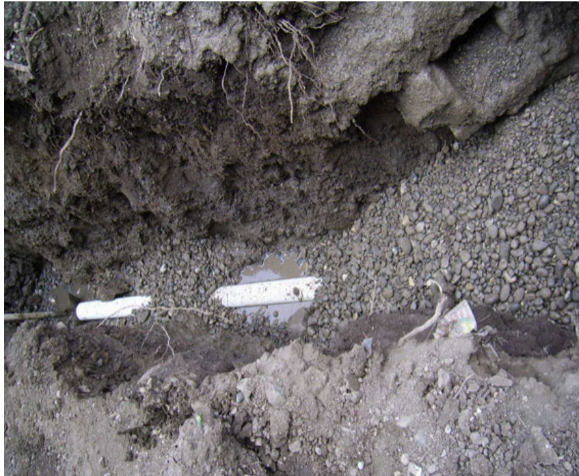
Foto N° 22: Sellado de subdrén con grava en una altura de 20 centímetros.
