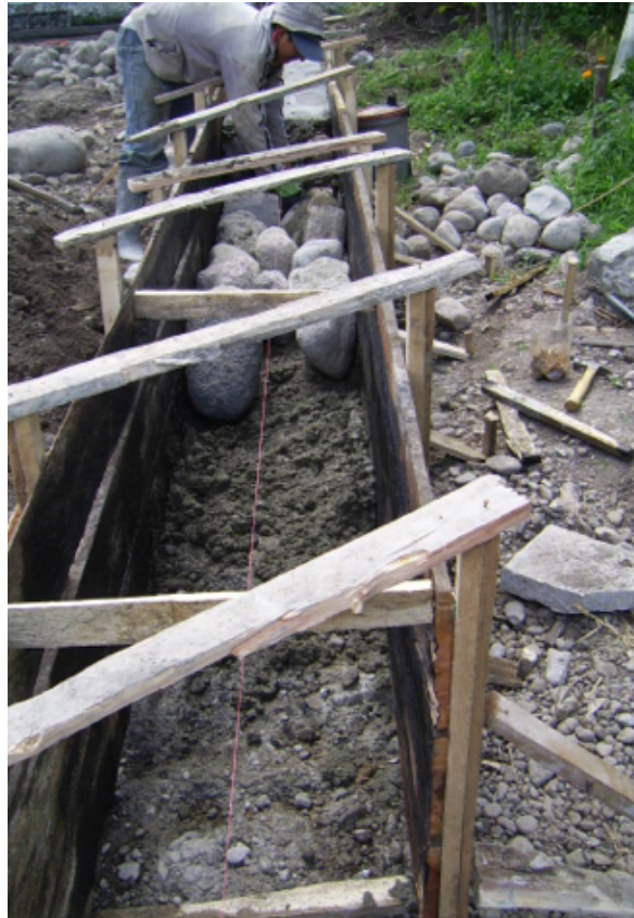
Foto N° 36: Relleno con mampostería de piedra sobre cimient , fundición de sobre cimient.
