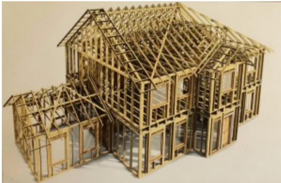
Imagen N° 25: vivienda construida con sistema de plataforma.
