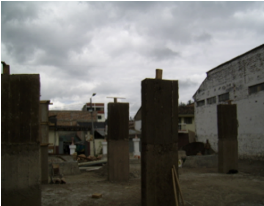
Foto N° 12: Detalle del encofrado de módulos de muros de tapial en obra.
