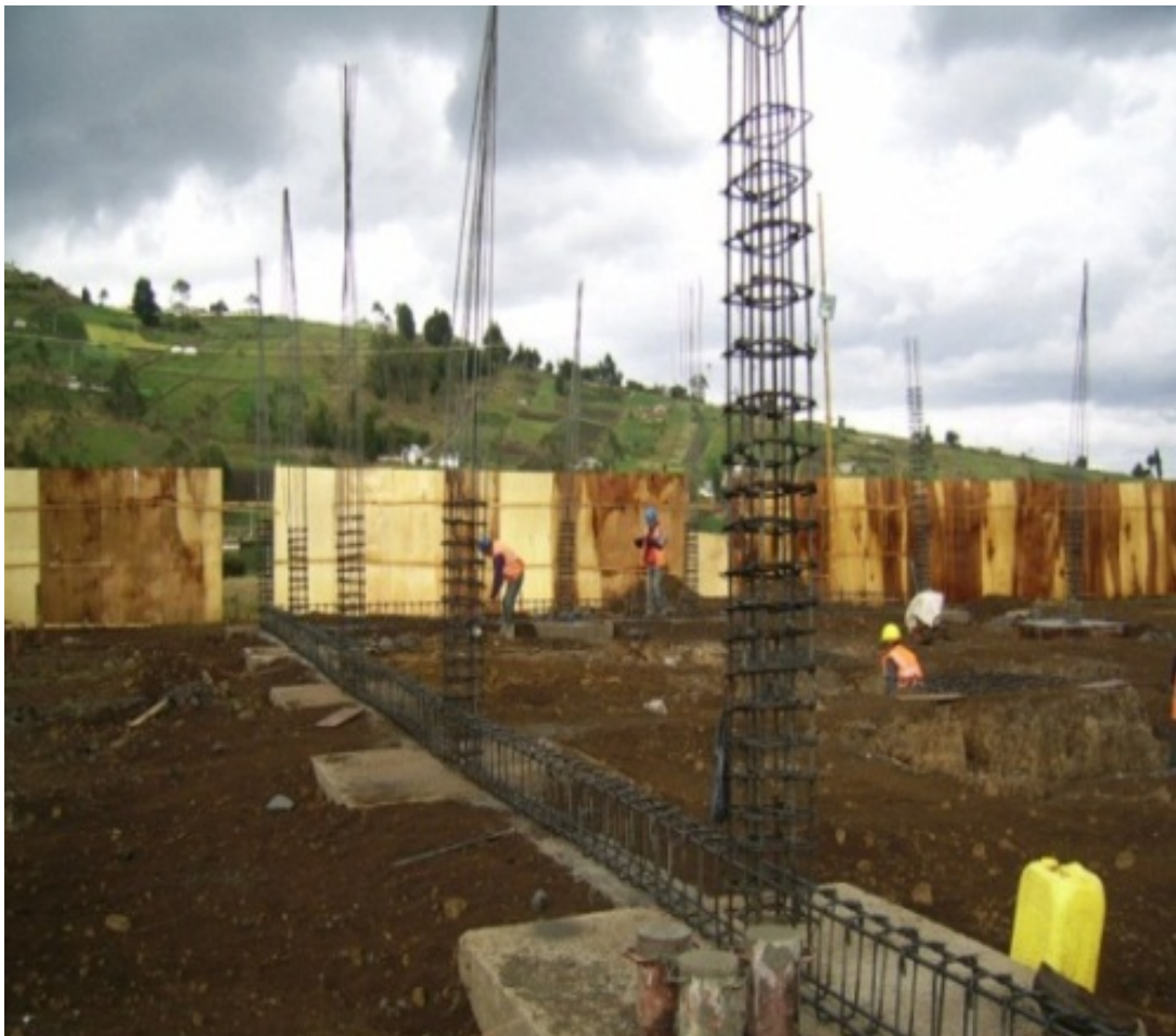
Foto N° 5: Detalle de armado de columna de hierro.
