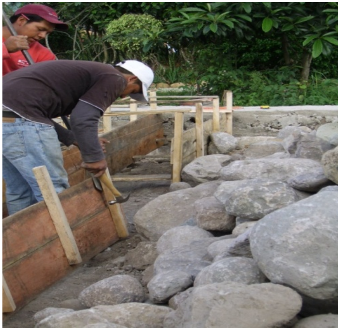
Foto N° 40: Encofrado recto de 30 centímetros de cimiento y 30 centímetros de sobre cimiento.
