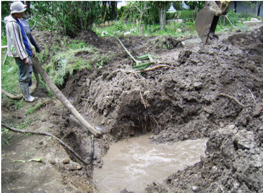
Foto N° 26: Excavación y desalojos adicionales para sub dren.
