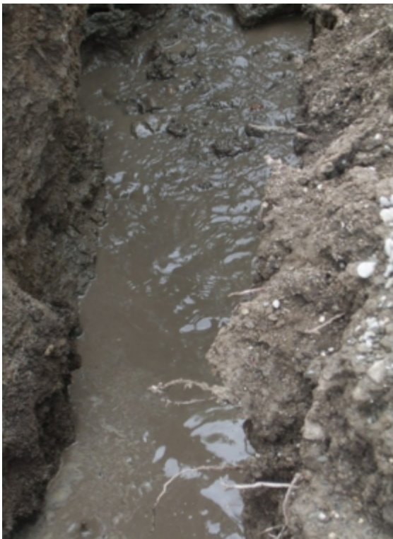
Foto N° 23 y N° 24: Presencia de aguas subterráneas que justifican la instalación de un subdren, evacuación de las aguas subterráneas con lo cual se da su justificación para su instalación.
