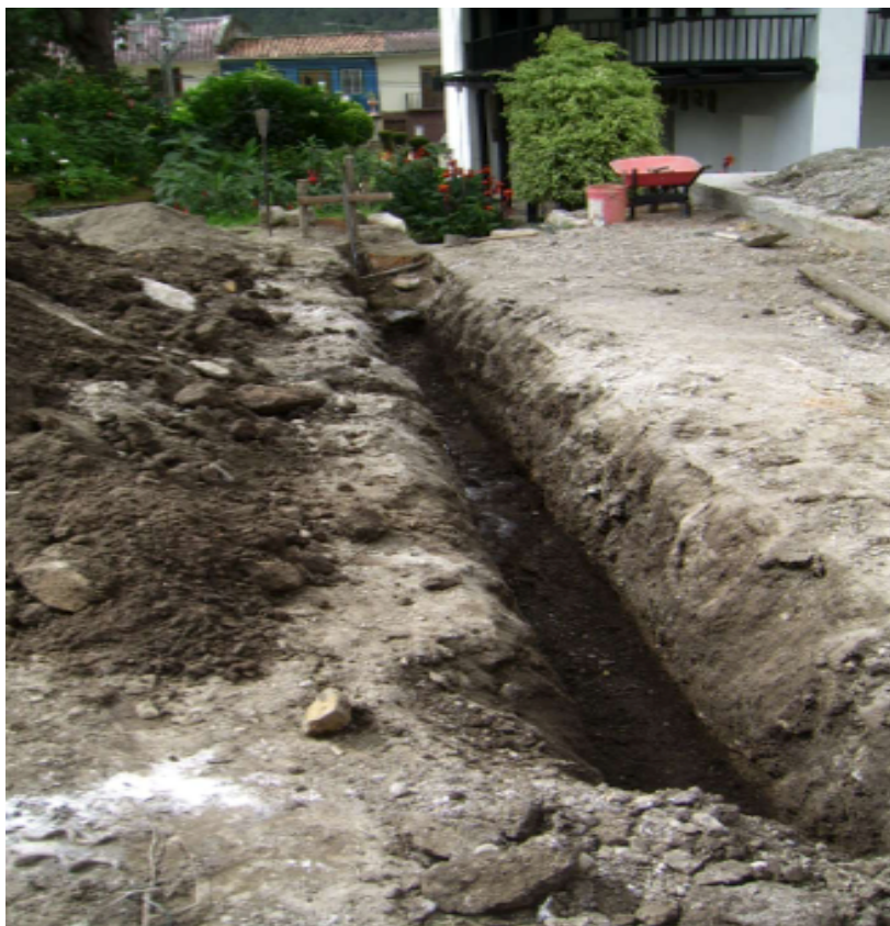
Foto N° 16: Excavación de cimiento.
