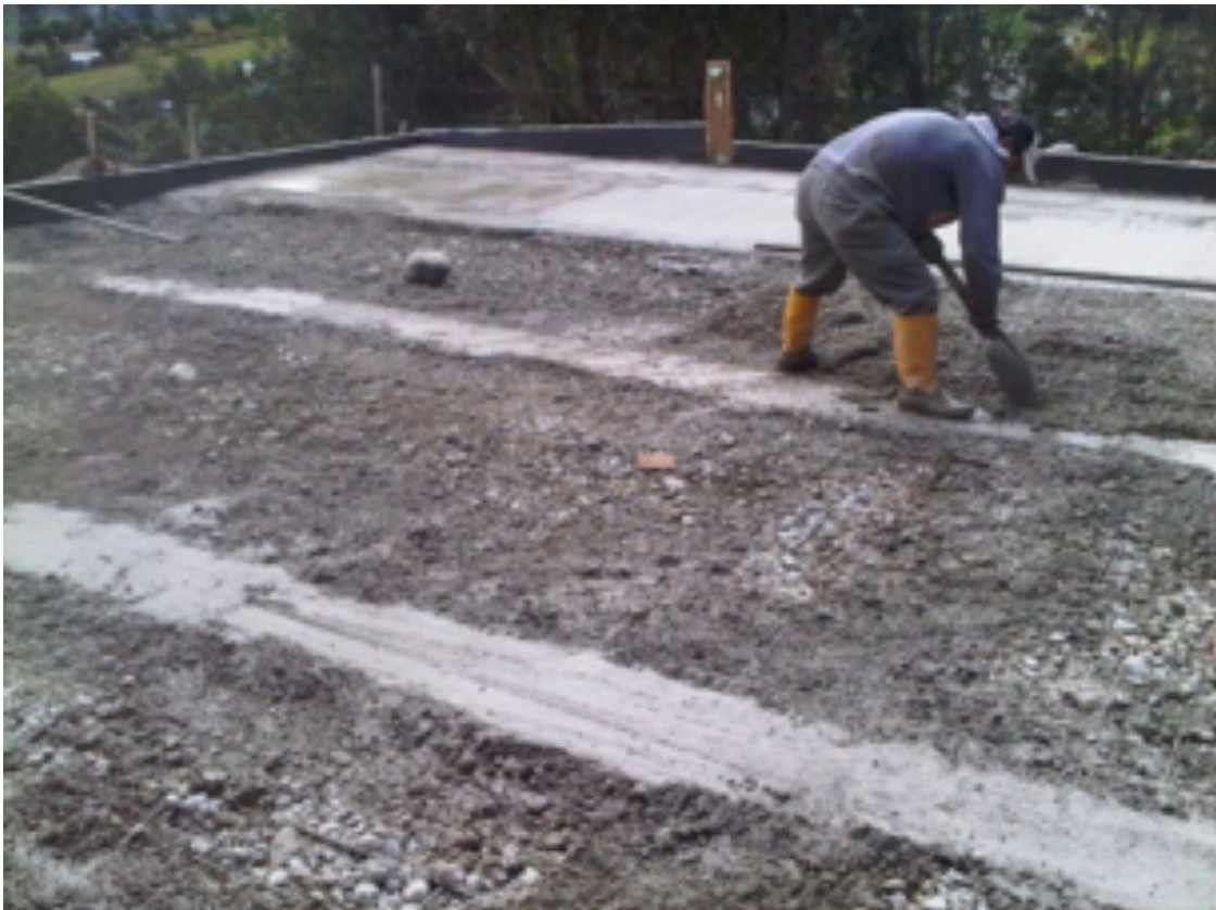
Foto N° 8: Detalle de fundición de losa hormigón armado, chapa de compresión.
