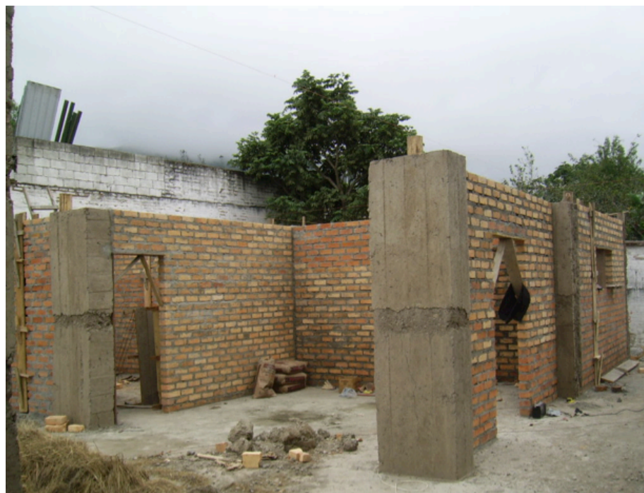
Foto N° 65: Detalle constructivo de columna, recubrimiento de pared de tapial y mampostería de bloque de pómez 10 x 20 x 40 centímetros.
