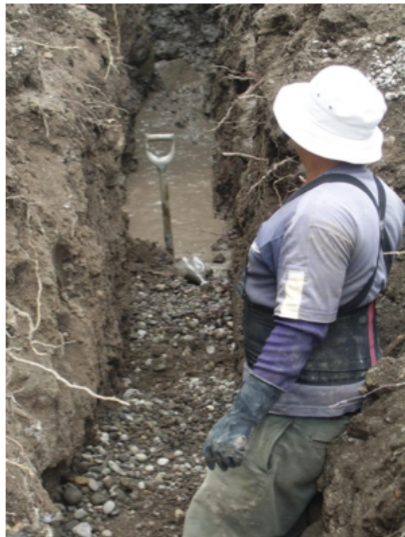
Foto N° 23 y N° 24: Presencia de aguas subterráneas que justifican la instalación de un subdren, evacuación de las aguas subterráneas con lo cual se da su justificación para su instalación.
