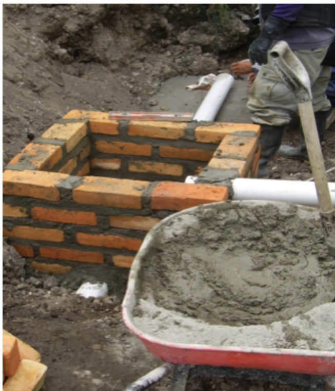
Foto N° 46: Armado de pozos de revisión, dimensiones 0,60 x 0,60 x 0,60 centímetros.
