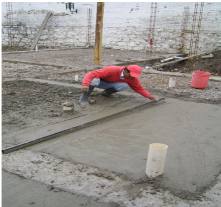
Foto N° 58: Fundición de chapa de compresión de 5 centímetros de espesor, piso a nivel = +/- 0,00
