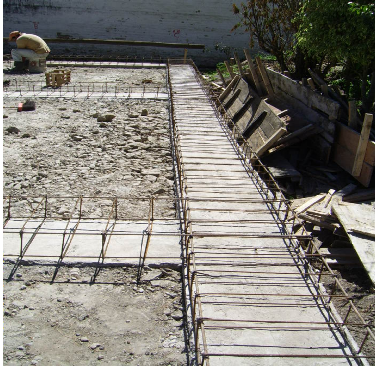
Foto N° 50: Armado y colocación de cadenas de hierro.
