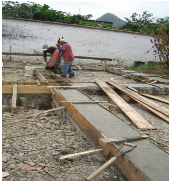
Foto N° 54: Instalación y Replanto de piedra de río de 15 centímetros entre cadenas de nivel = +/- 0,00.
