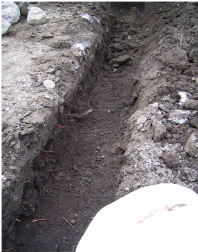
Foto N° 42: Excavación para red de aguas servidas.
