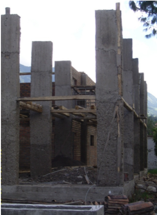
Foto N° 81: Armado de estructura de cubierta, vigas perimetrales de 16 x 16 cm.
