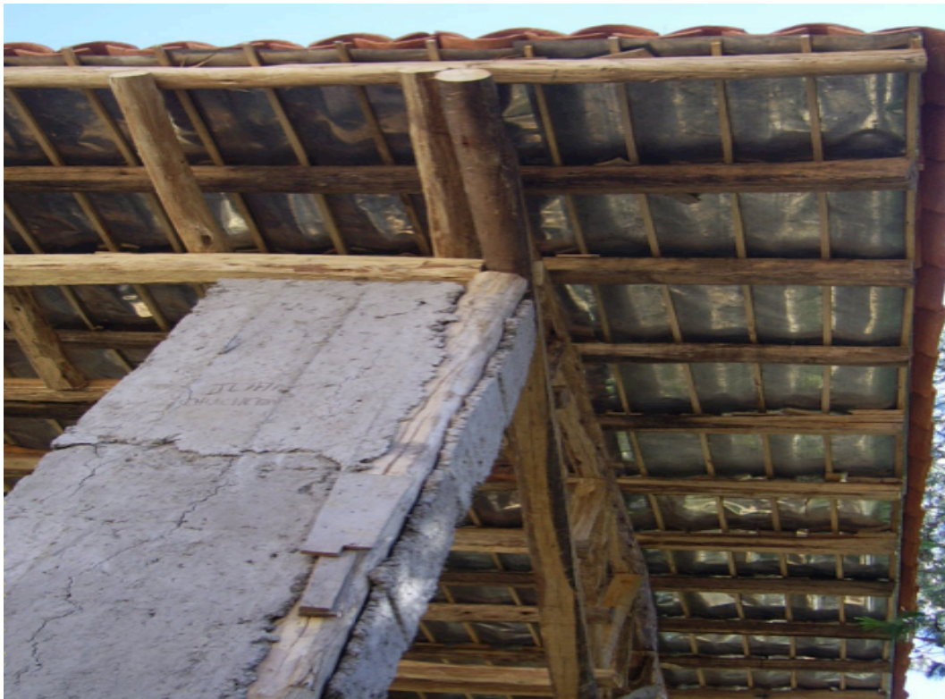
Foto N° 86: Detalle de impermeabilización de cubierta mediante uso de zinc armado sobre tirillas.
