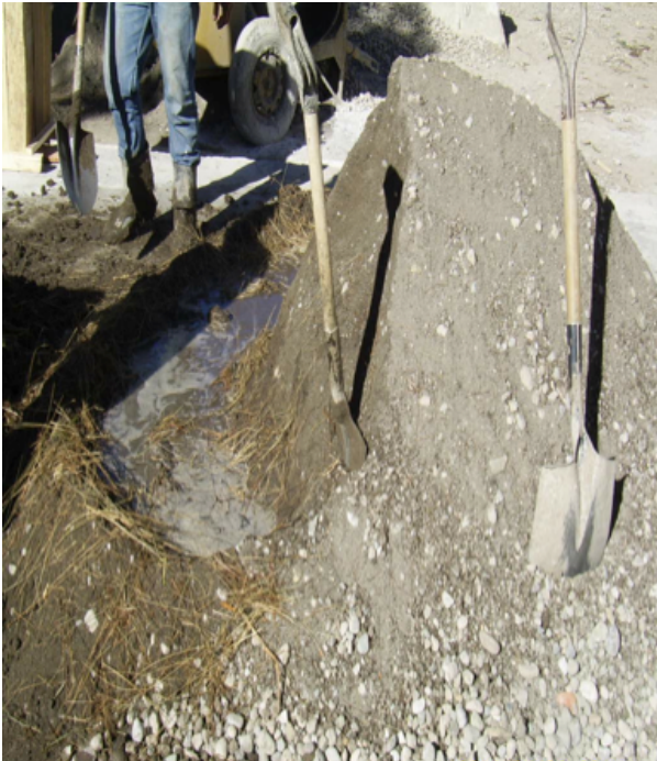
Foto N° 63: Preparación de materiales para paredes de tapial.
