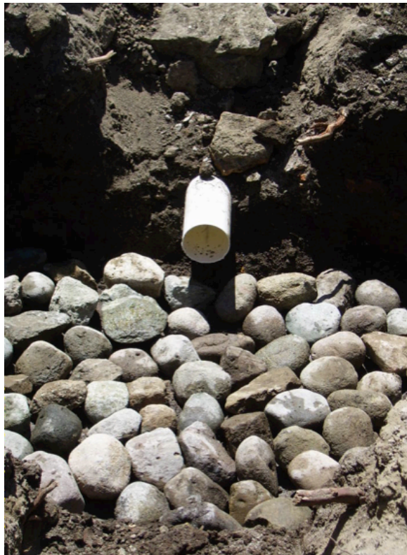
Foto N° 46: Armado de pozos de revisión, dimensiones 0,60 x 0,60 x 0,60 centímetros.
