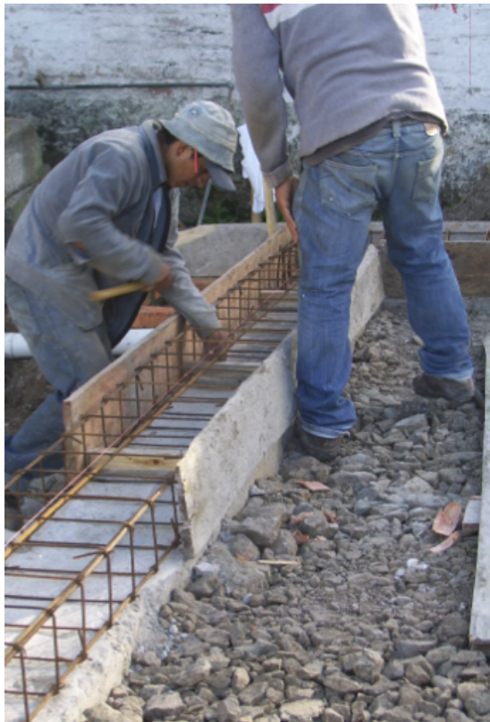
Foto N° 52: Encofrado recto para cadenas de hierro a nivel = +/- 0,00.
