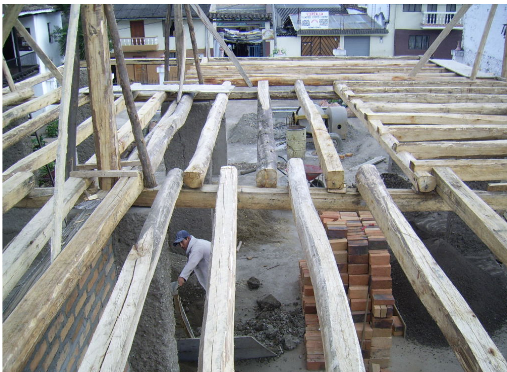
Foto N° 71: Colocación de columnas de 16 x 16 centímetros, primera planta alta, armado y colocación de columnas.
