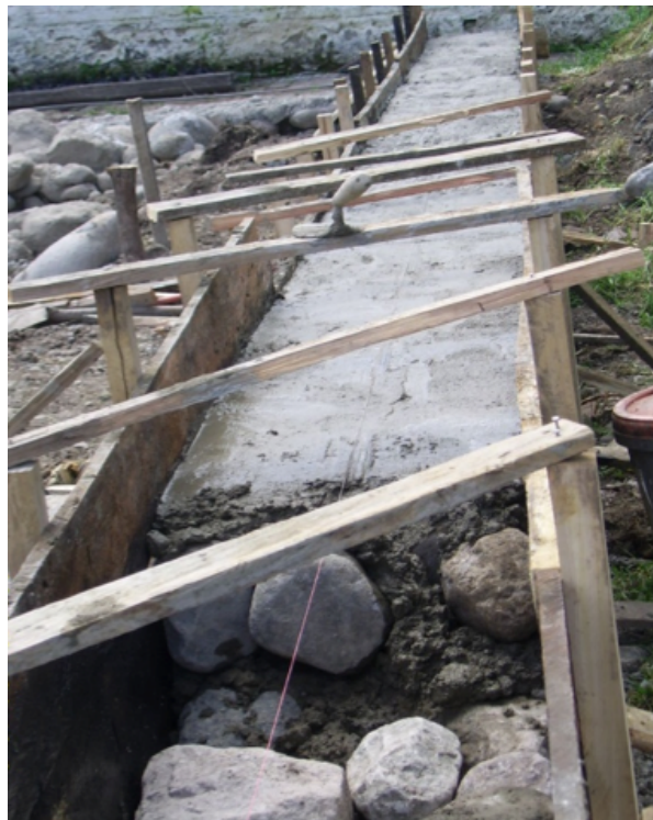
Foto N° 36: Relleno con mampostería de piedra sobre cimient , fundición de sobre cimient.
