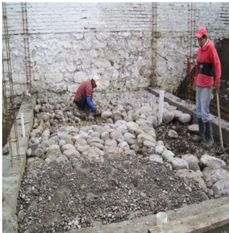
Foto N° 54: Instalación y Replanto de piedra de río de 15 centímetros entre cadenas de nivel = +/- 0,00.
