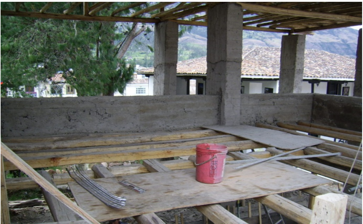
Foto N° 91: Antepecho de tapial en planta alta.
