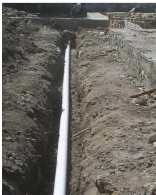
Foto N° 34: Tendido de Tubería de pvc de 110 mm para desagüe de aguas lluvias.
