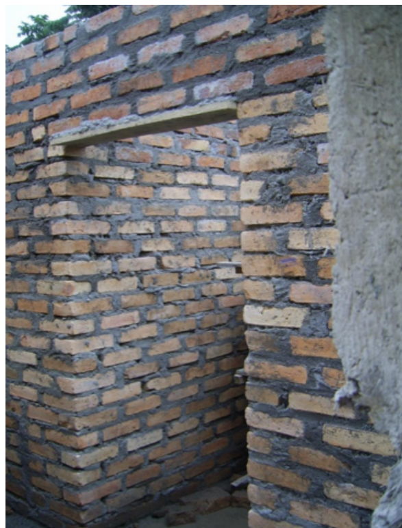
Foto N° 69: Armado de dinteles de puertas en mampostería de ladrillo.
