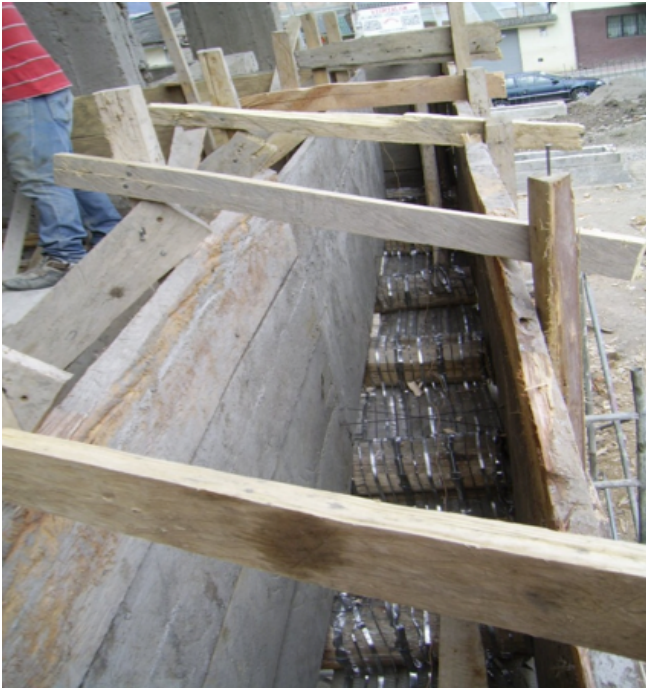
Foto N° 89 – Foto N° 90: encofrado recto en planta alta para antepecho de tapial, vista superior e inferior.
