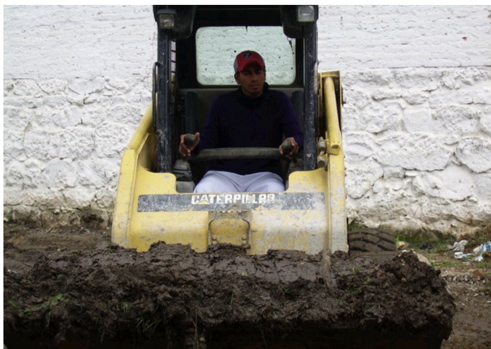
Foto N° 38: Desalajo con bobcat de material producto de la excavación de cimientos.
