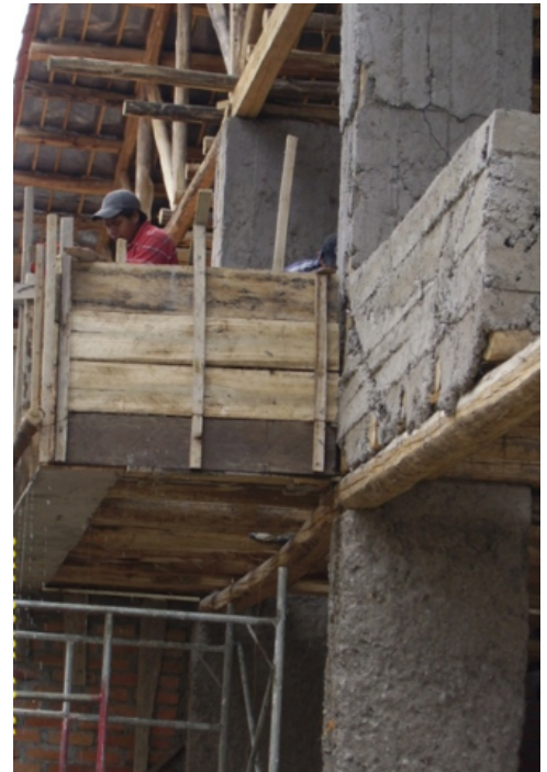
Foto N° 89 – Foto N° 90: encofrado recto en planta alta para antepecho de tapial, vista superior e inferior.
