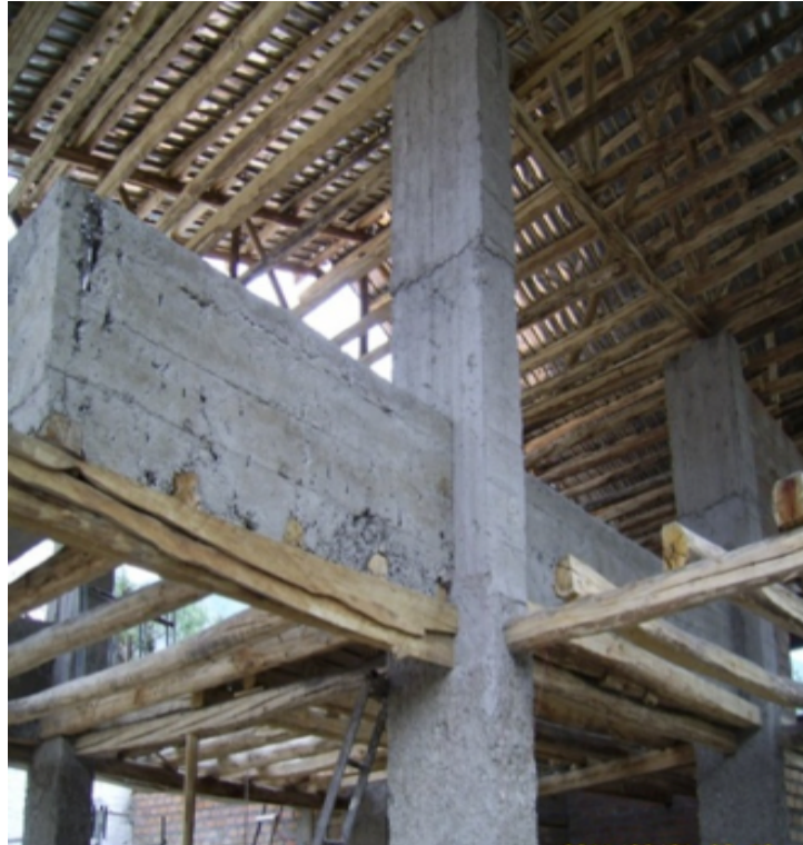
Foto N° 93: Encofrado recto de madera para antepecho de tapial en planta baja.
