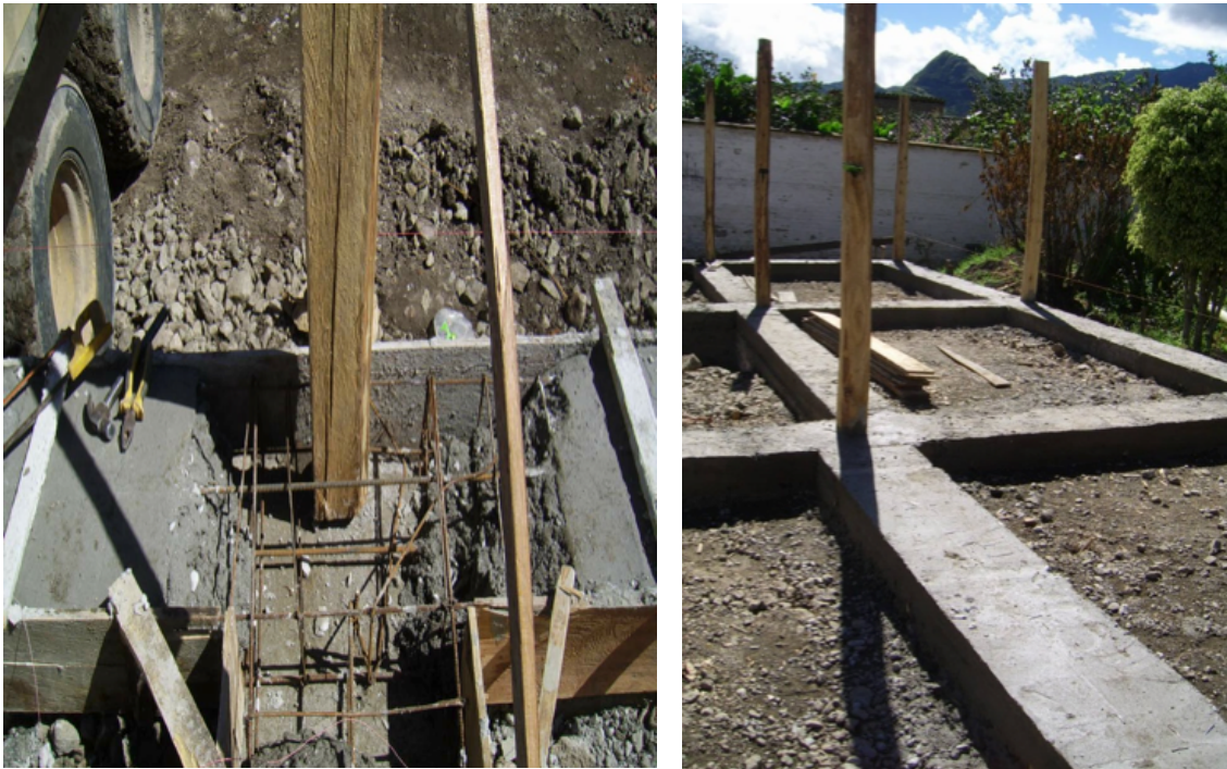
Foto N° 62: Encofrado de madera para mampostería de tapial.
