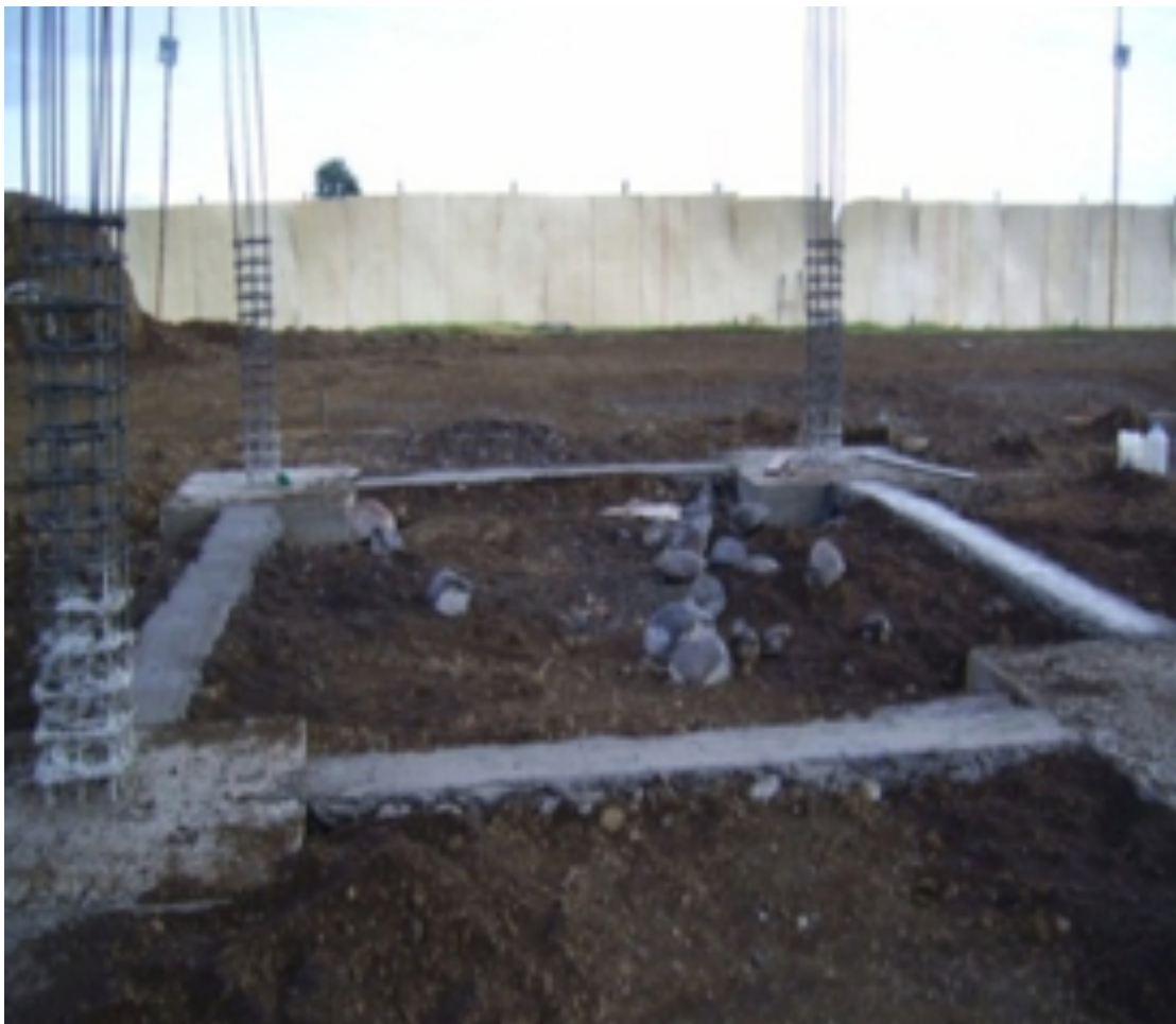
Foto N° 4: Armadura de hierro para columna y empotramiento en la cimentación.
