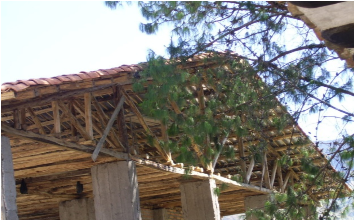
Foto N° 83: Estructura de cubierta y cubierta en teja artesanal.
