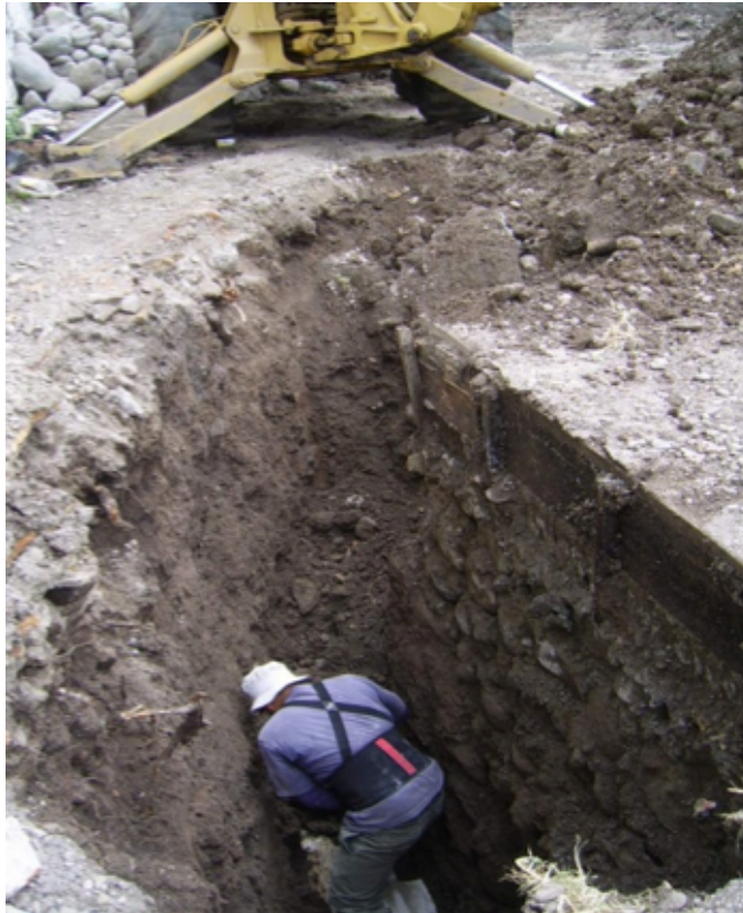
Foto N° 18: Excavación manual profunda para cimentación de obra.
