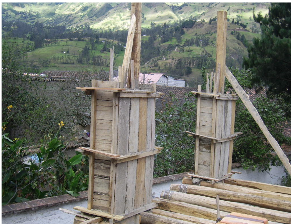
Foto N° 73: Encofrado de madera para mampostería de tapial en primera planta alta.
