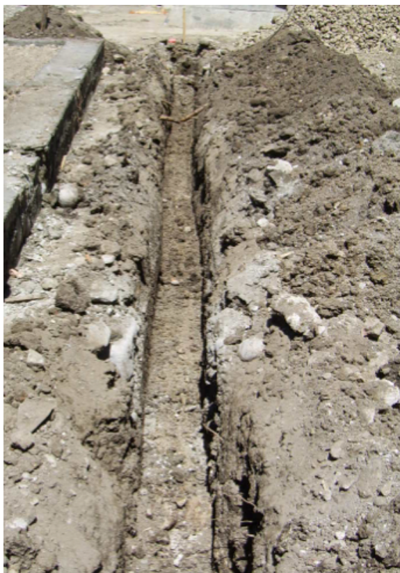
Foto N° 34: Tendido de Tubería de pvc de 110 mm para desagüe de aguas lluvias.
