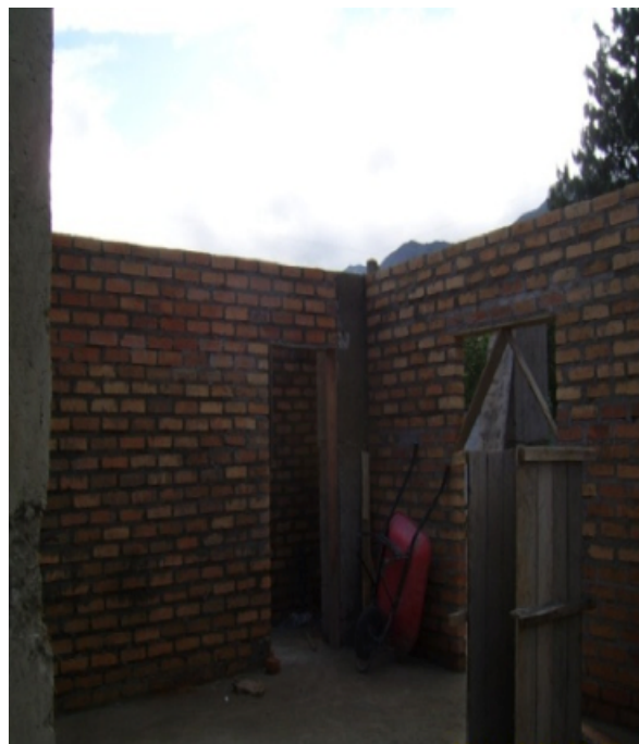
Foto N° 69: Armado de dinteles de puertas en mampostería de ladrillo.
