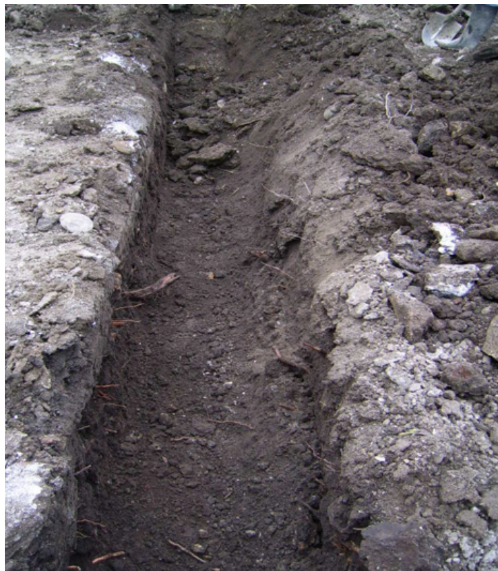
Foto N° 29: Excavación de cimiento de 0,50 centímetros de ancho x 1,20 centímetros de profundidad.
