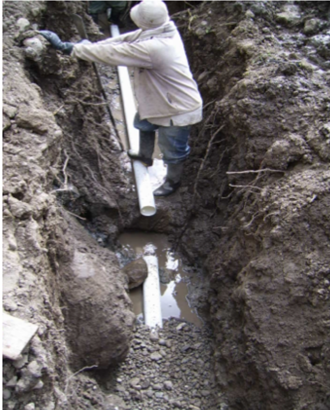
Foto N° 26: Excavación y desalojos adicionales para sub dren.
