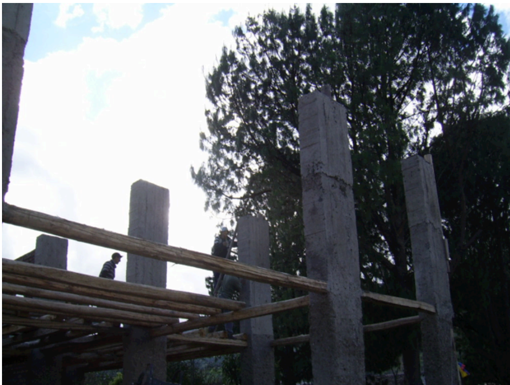
Foto N° 75: Mampostería de tapial vista de planta baja y planta alta.
