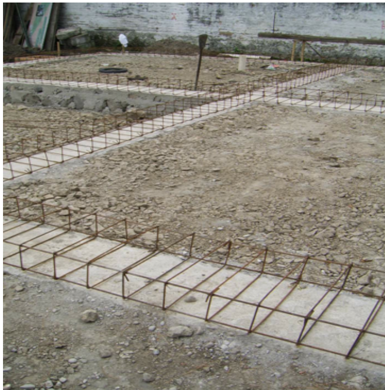
Foto N° 50: Armado y colocación de cadenas de hierro.
