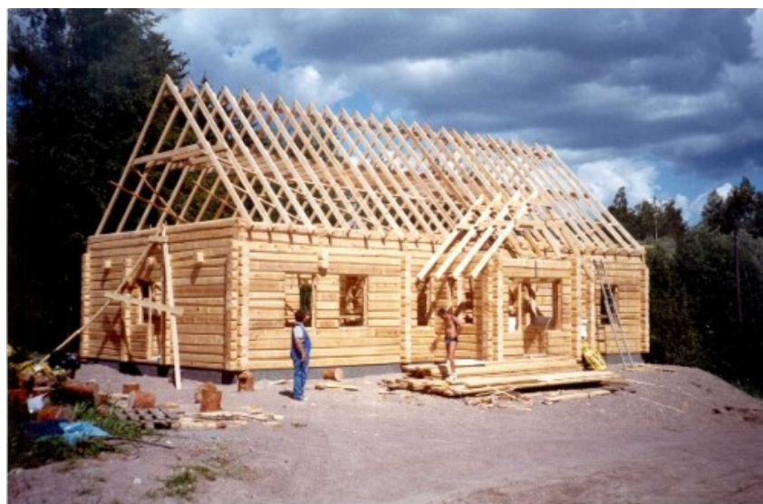
Imagen N° 26: Vivienda construida con elementos macizos.
