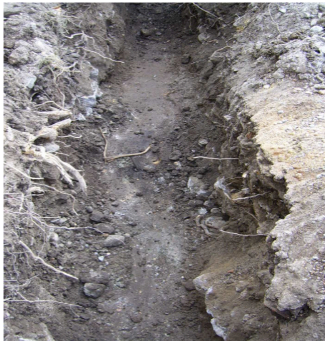
Foto N° 44: Relleno compactado con material de mejoramiento en capa de 30 centímetros.
