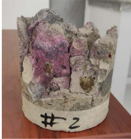
Ilustración 28. Muestras roseadas para ensayo de carbonatación.
