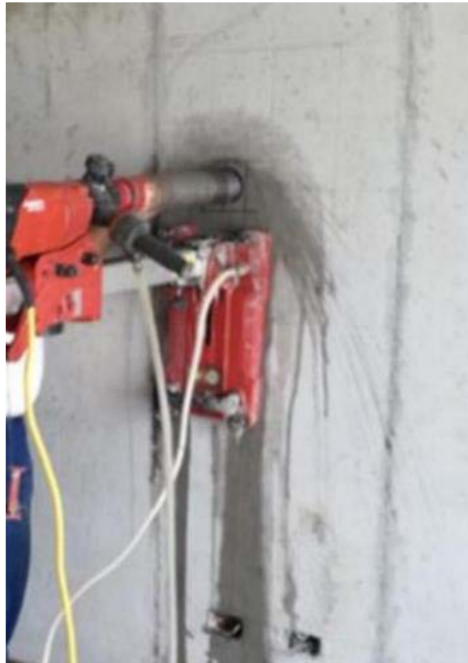
Ilustración 7. Análisis de la resistencia del concreto por medio de la extracción de núcleo
