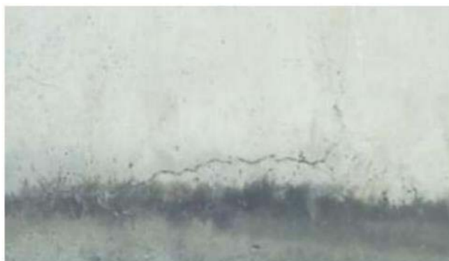
Ilustración 4. Fisuras
